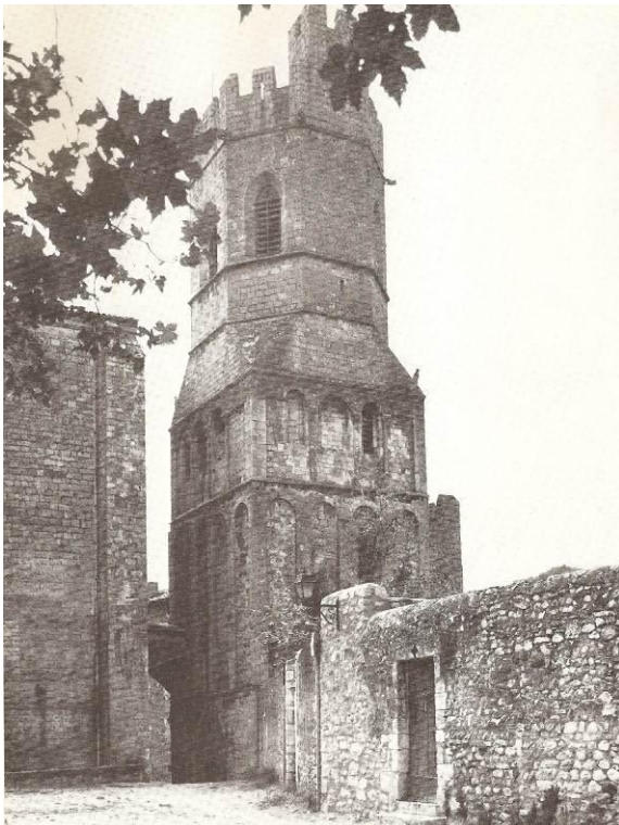
Abb. 73: Frankreich, Turm der St.-Vincent Kathedrale in Viviers (14. Jh.)
