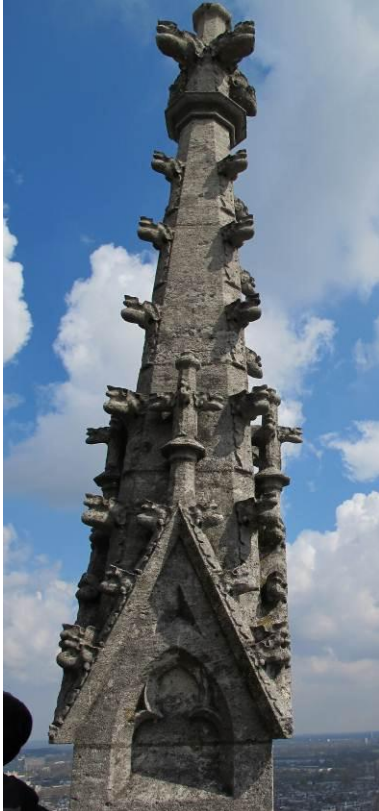
Abb. 54: Beispiel für die Fialtürme an den Ecken des Oktogons
