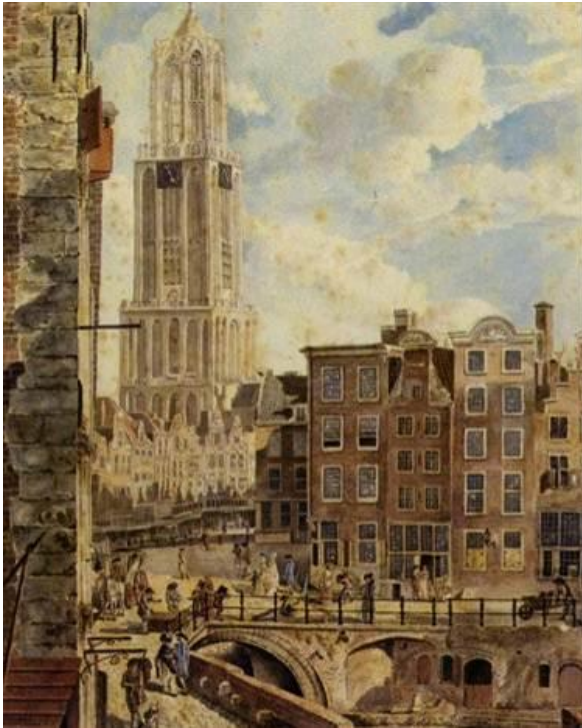
Abb. 35: C. van Hardenberg, Blick auf den Domturm von der Oudegracht (1782), Archiv Utrecht
