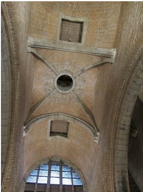
Abb. 62: Michaelskapelle, Wölbung des „Mittelschiffes“
