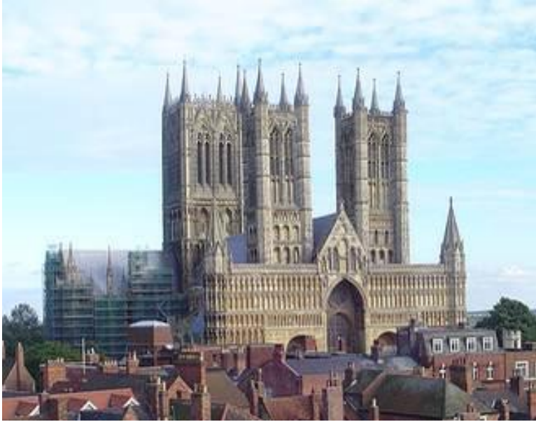
Abb. 100: England, Kathedrale von Lincoln, Blick von Nord-West
