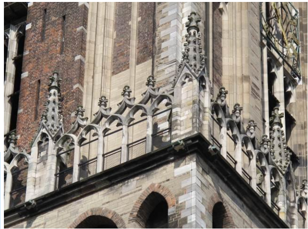
Abb. 49: Balustrade I oberhalb des untersten Turmgeschoßes, von Süd-Osten
