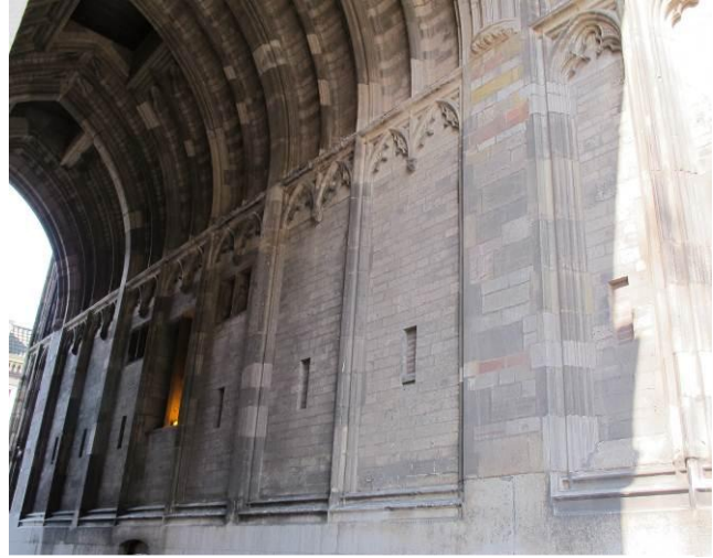
Abb. 48: Gewölbe und Wandzone der Durchfahrtsöffnung
