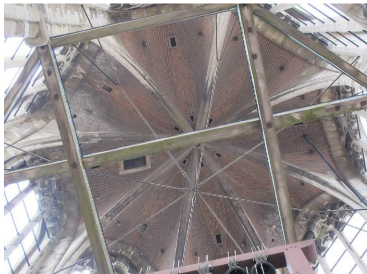
Abb. 57: achteiliges Sterngewölbe im Inneren der polygonalen Turmlaterne
