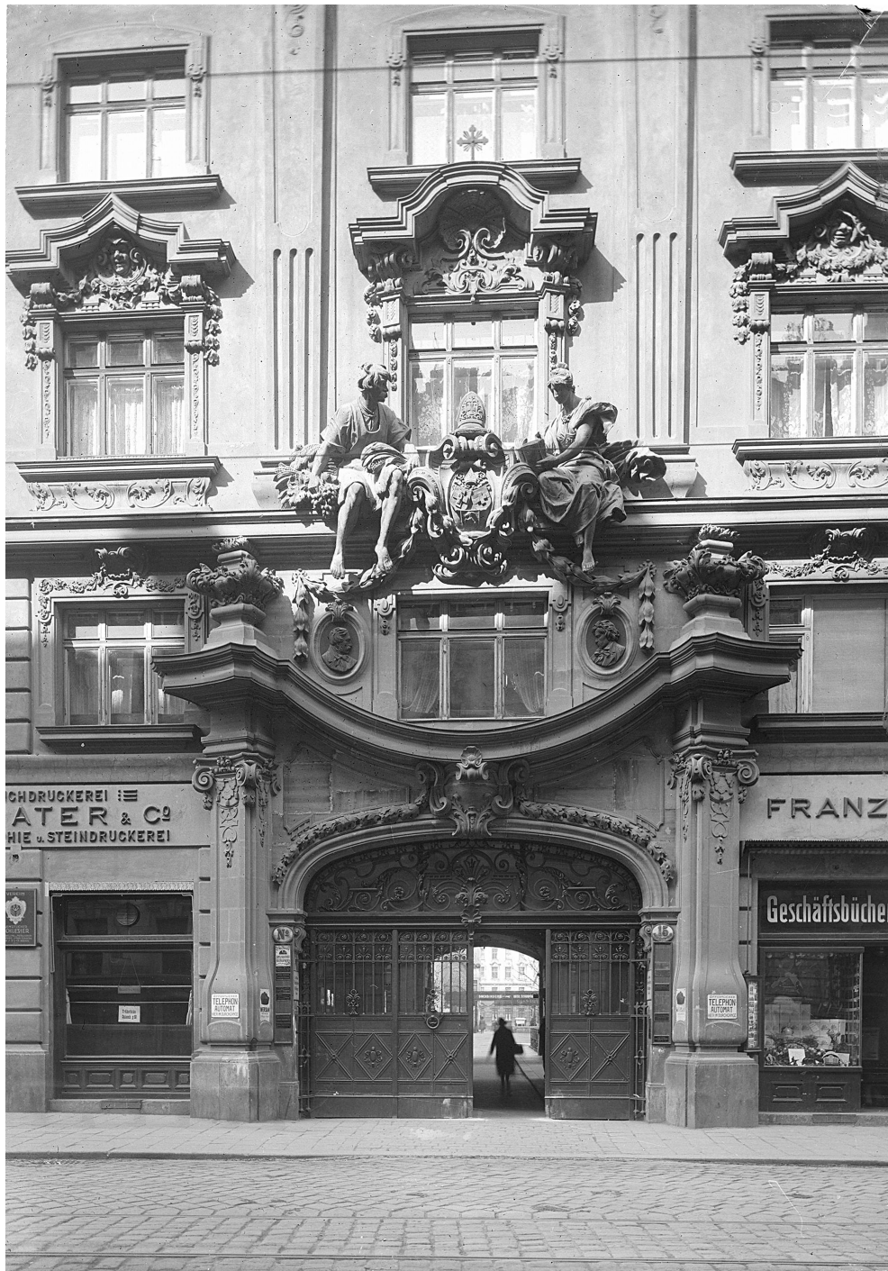
Abbildung 14: Portal Schwarzspanierhof, Originalzustand
