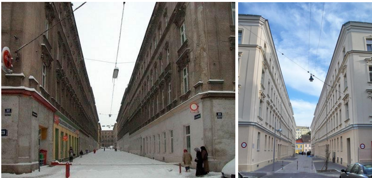
Abbildung 7: Kauerhof vor und nach der Sanierung (HASALTAY 2004, LIPPL 2008)
