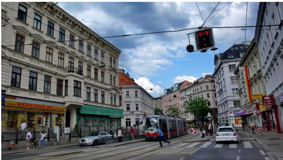
Abbildung 31: Äußere Mariahilferstraße (LIPPL 2012)
