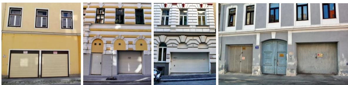
Abbildung 41: Nachträglich errichtete Garagen (LIPPL 2011)
