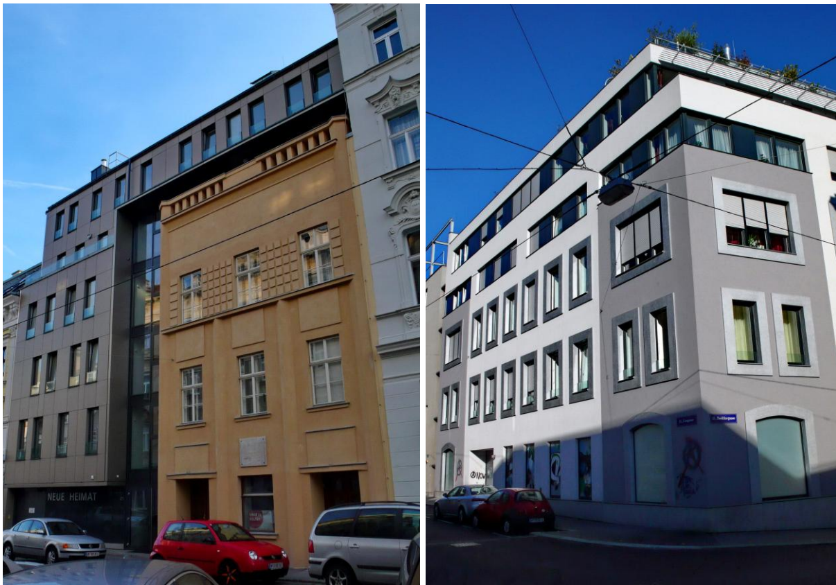
Abbildung 40: ModernerRenovierungen mit Aufstockungen, links mit Zubau (LIPPL 2011)
