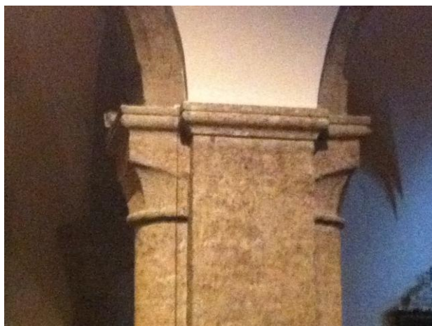
Abbildung 12: Franziskanerkirche Mittelschiff, Pfeiler
