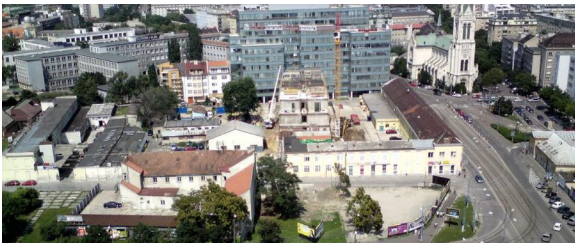
Abbildung 3.18.: Grüneberg Brüsten Fabrik wird zum Teil in ein Hotel umgebaut. (Quelle: http://www.skyscrapercity.com/showthread.php?t=900892 ; Stand 26.5.2012)
