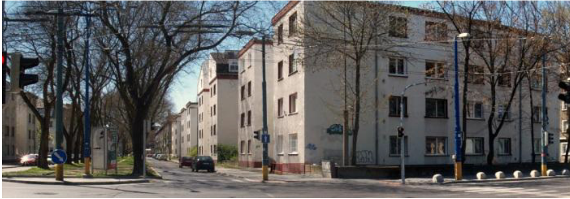
Abbildung 1.11.: Die Arbeiterkolonie von E. Belluš in Bratislava aus dem Jahr 1931 auf beiden Straßenseiten ist auch als Kolonie der kleinen Wohnungen bekannt. (Autor: Dr. Patrik Guldán)
