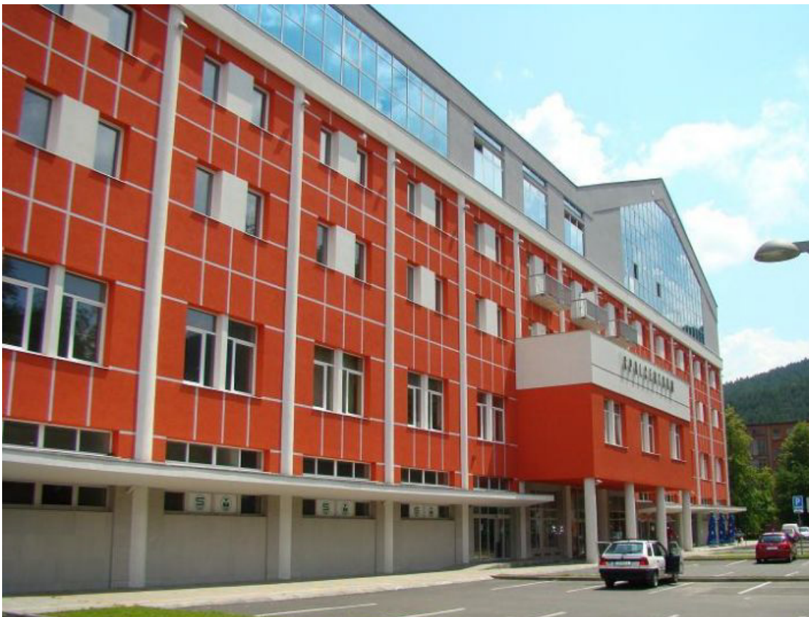
Abbildung 3.15.: Eine stark unempfindliche Umbaut des Hauses in sogenanntem Bat'a-Styl in ein Hotel in der Stadt Svit. (Autor des Bildes: Hotel Spolcentrum)
