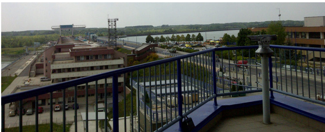
Abbildung 3.8.: Das riesige Wasserkraftwerk in Gabčíkovo. (Quelle: Eigenes Archiv des Autors)
