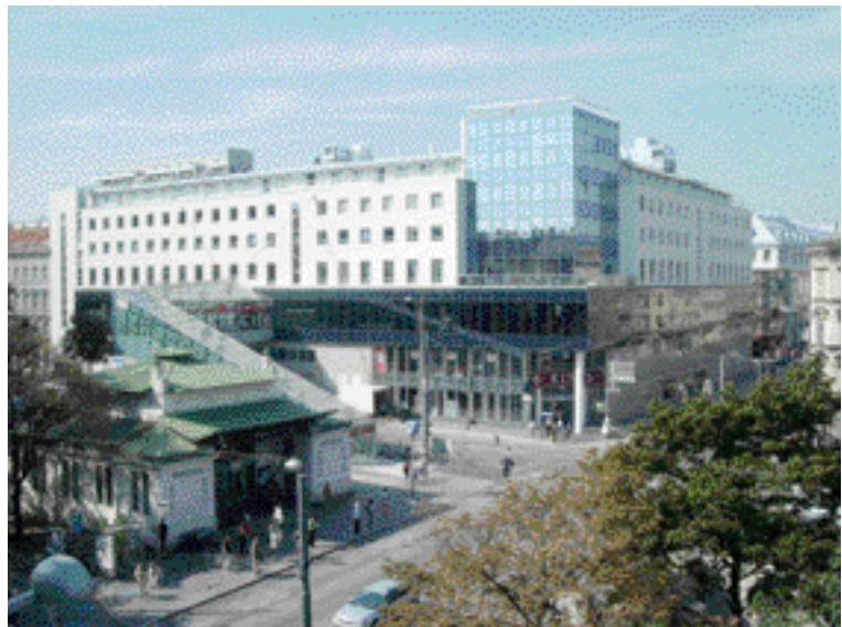
Bild 4: Eingang Gürtel (E3), neuer Bauteil, und Gürtelbrücke mit Eingang (E4).
