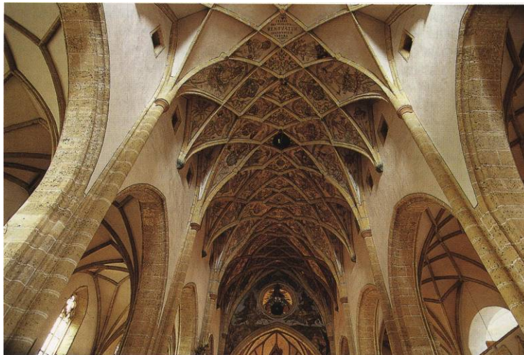
Abb. 120: Maria Saal, Pfarrkirche, Gewölbe.
