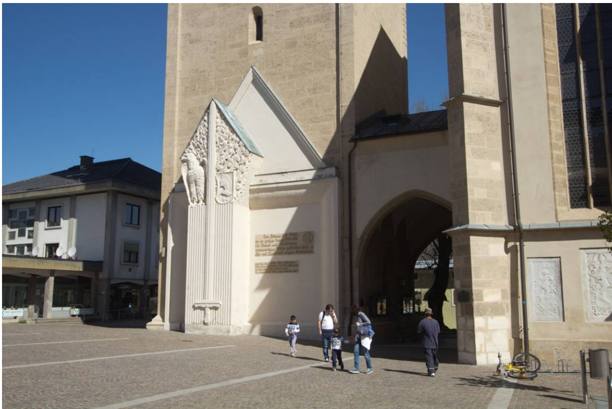
Abb. 12: St. Jakob, Südseite 2012.
