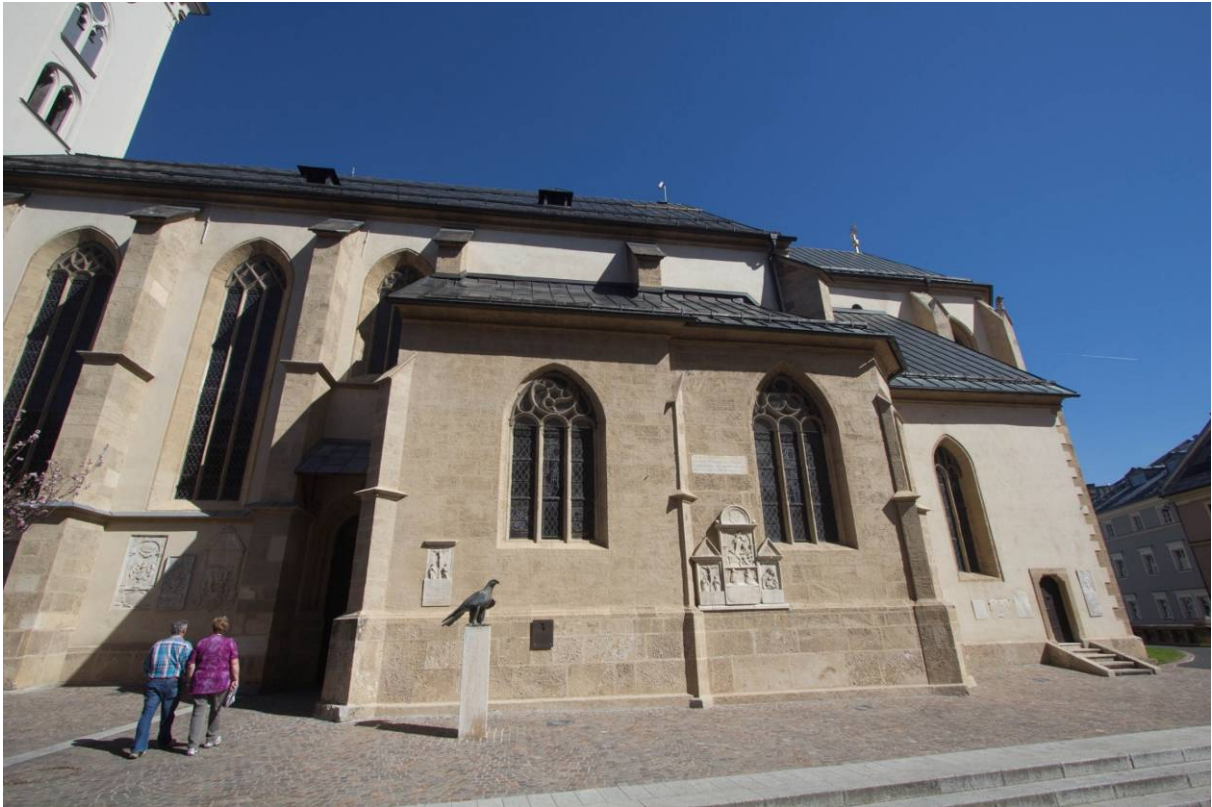
Abb. 11: St. Jakob, Südseite, 2012.
