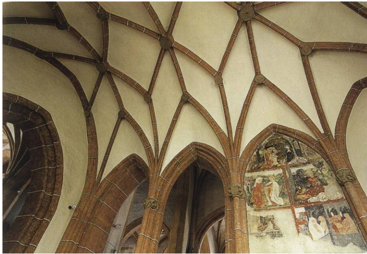
Abb. 119: Völkermarkter Stadtpfarrkirche, Gewölbe.
