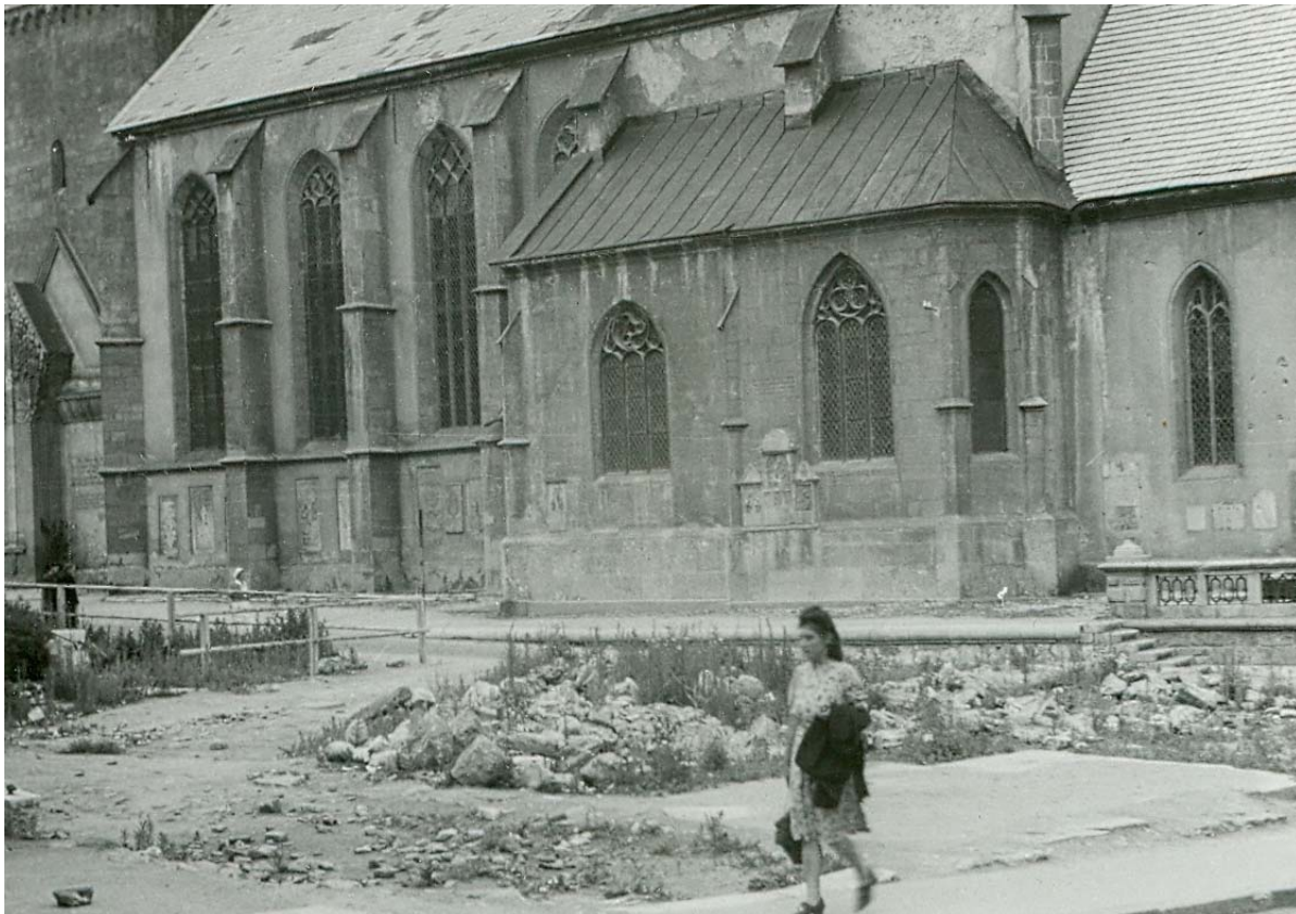
Abb. 80: St. Jakob, Südseite, 1947.
