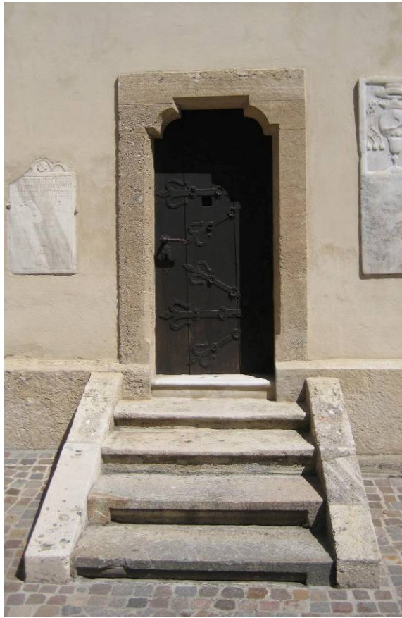
Abb. 23: St. Jakob, Eingang zur Sakristei, 2012.
