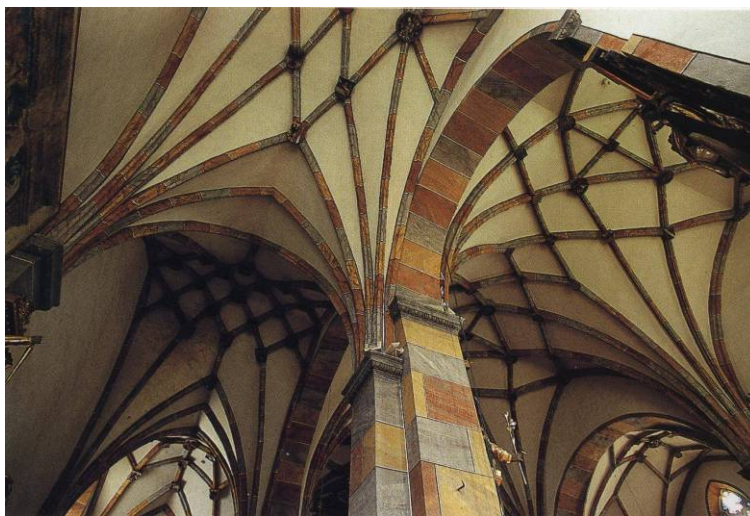
Abb. 121: Millstatt, Pfarrkirche, Gewölbe.
