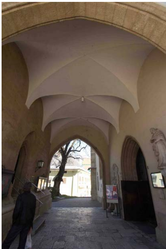
Abb. 17: St. Jakob, Vorhalle, 2012.
