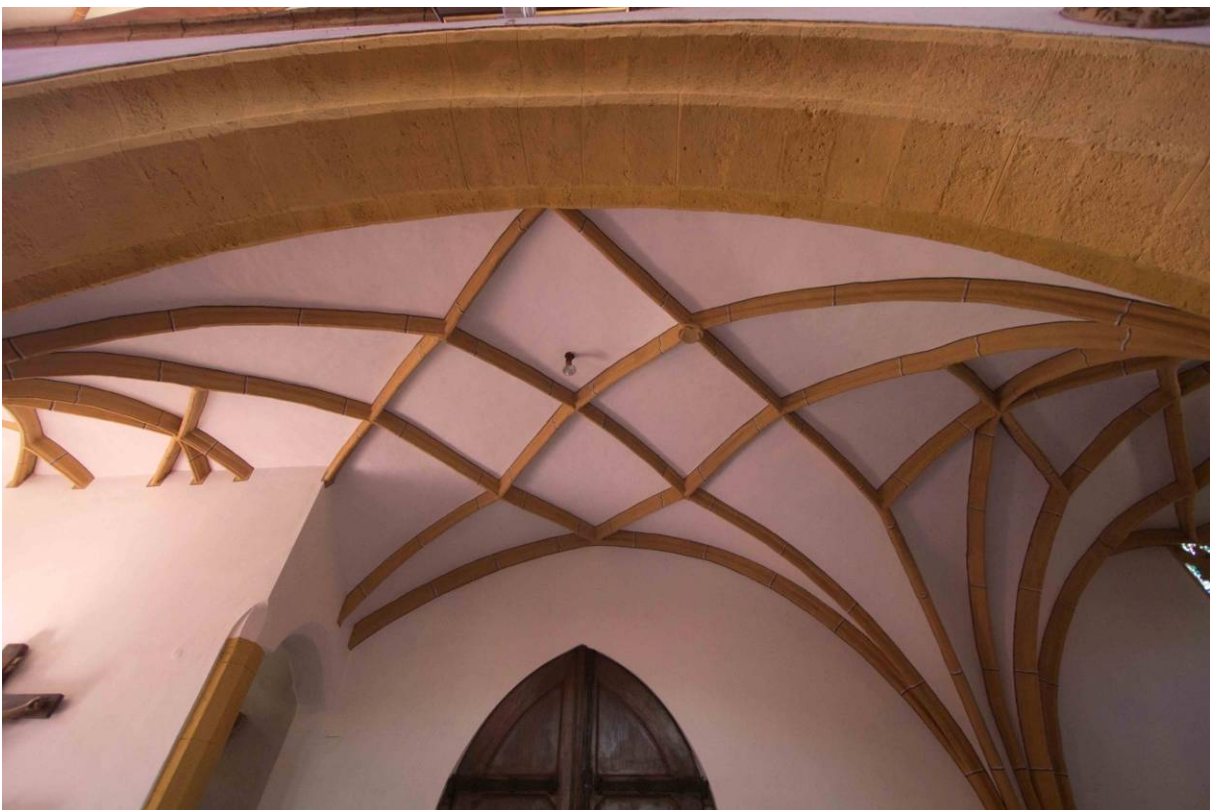
Abb. 30: St. Jakob, Gewölbe unter Westempore, 2012.
