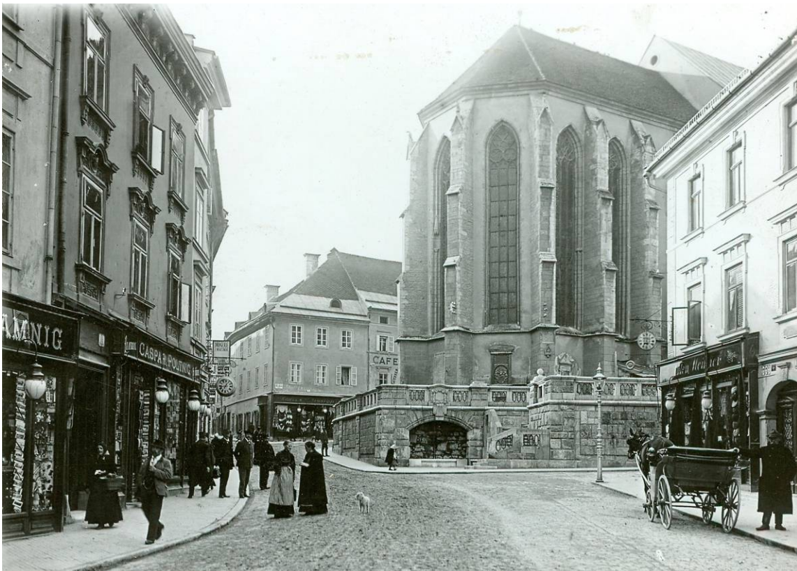
Abb. 10: Villach, nach dem Abriss des Rautterhauses, nach 1906.
