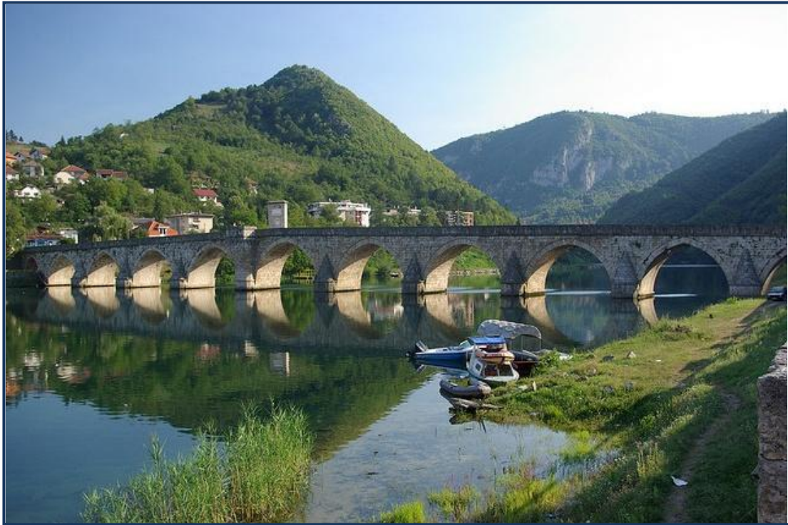
Abbildung 6: Die Brücke über die Drina in Višegrad 79
