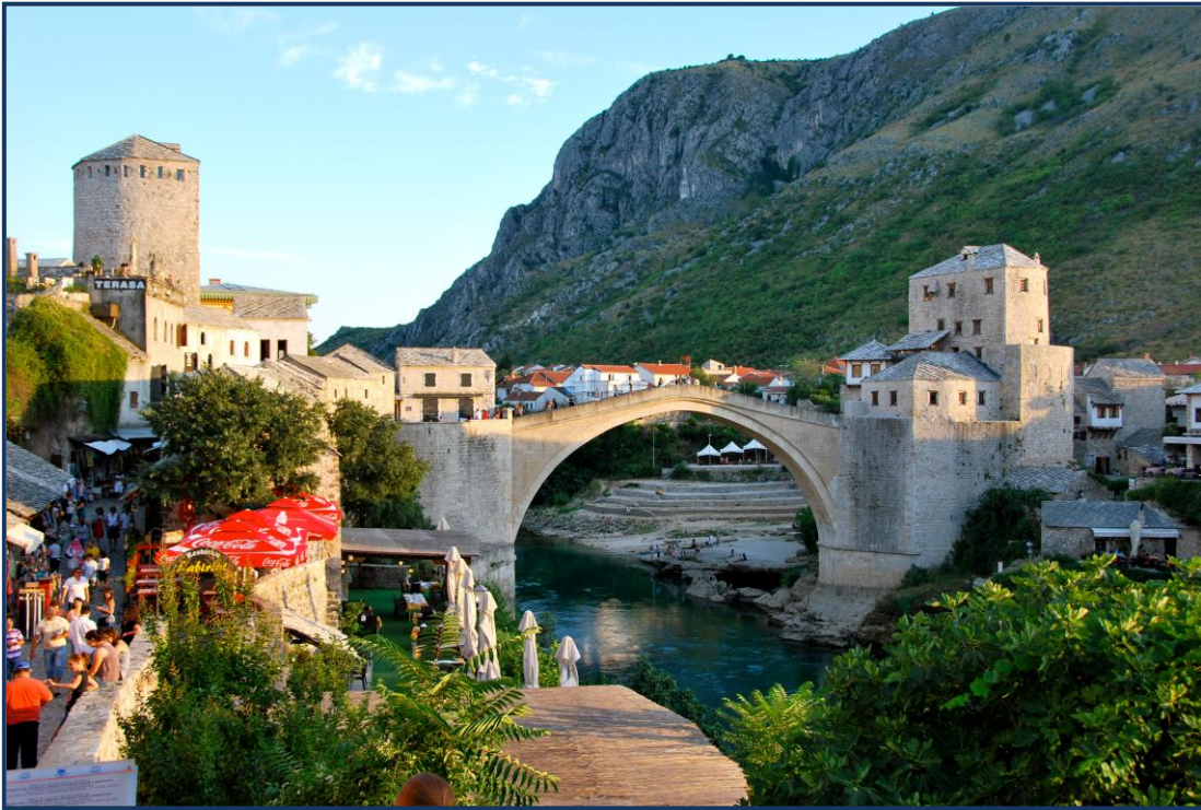
Abbildung 5: Neue Alte Brücke in Mostar 75
