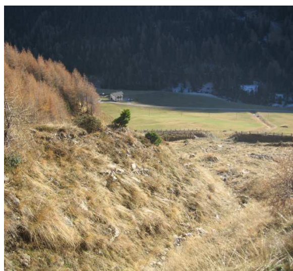
Abbildung A.18: Außervallatschbach, Verbauung
