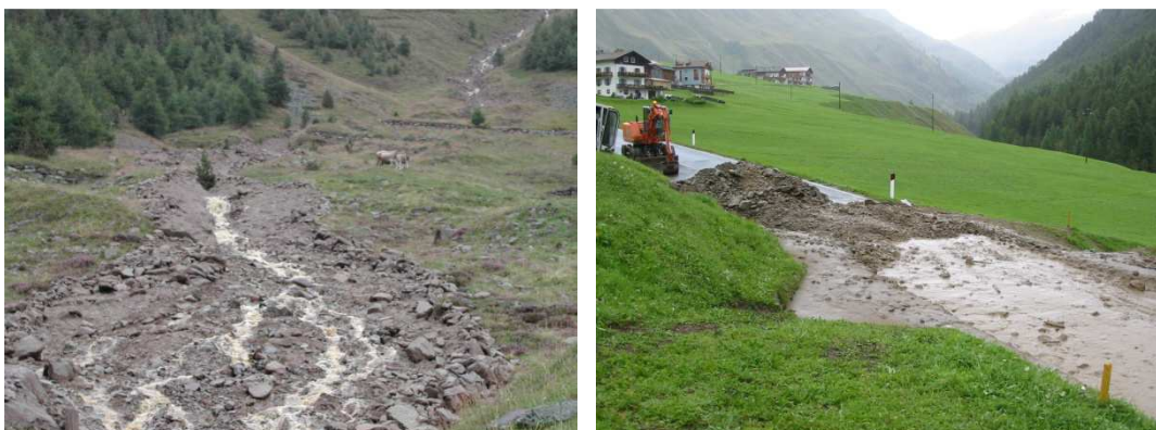
Abbildung A.30: Murgang im Außervallatschbach vom 23.08.2005 (Quelle: ED30)
