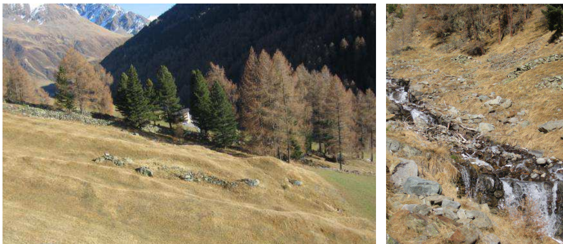
Abbildung A.14: Patscheiderbach, Murkegel (links) und Mittellauf mit Ablagerungen (rechts)
