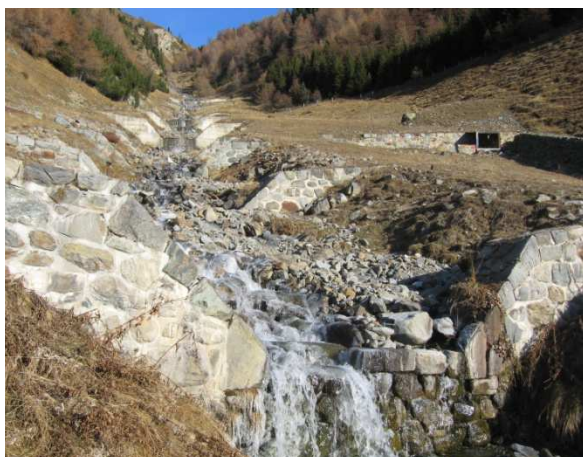
Abbildung A.16: Kapplerbach, Konsolidierungssperren (links) und Erosionskanal (rechts)
