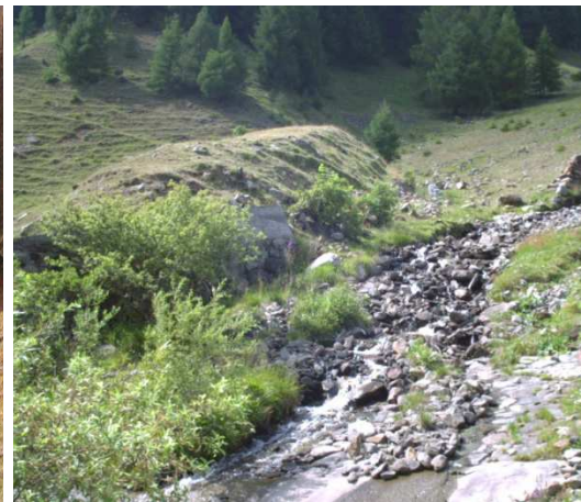
Abbildung A.13: Patzinbach, Verbauung (Quelle: BAUKAT30)
