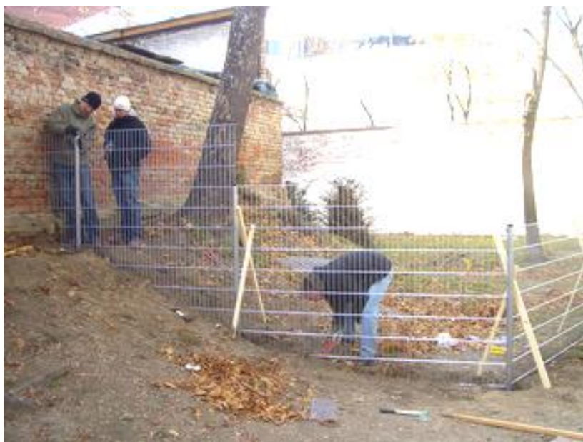
Abb. 19: Beim Zaunaufstellen. Quelle: graetzlgarten9
