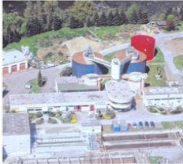
Betriebsbereit. Die Biogasanlage in Leoben könnte bis Jahresende wieder den Vollbetrieb aufnehmen.
