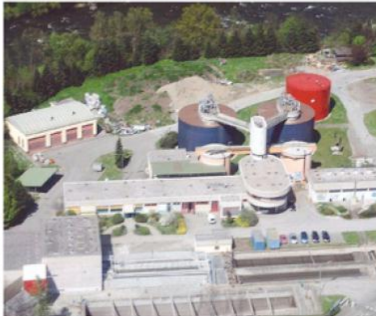
Seit Juni des Vorjahres ist die Biogasanlage Leoben wegen Baumängel geschlossen. Eine Wiederinbetriebnahme könnte im Frühjahr erfolgen. Bayer
