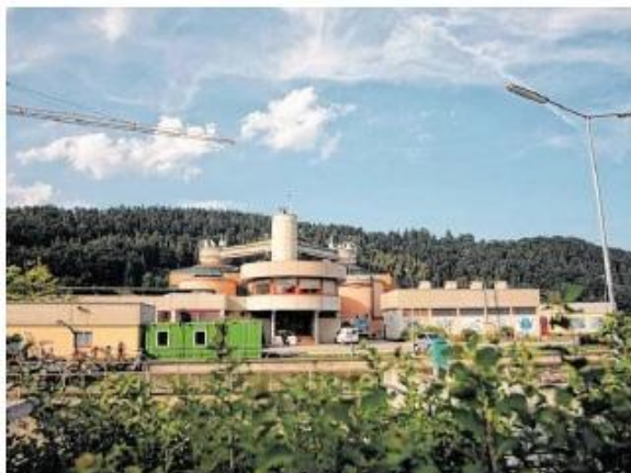
Die Biogasanlage in Leoben steht zur Erleichterung der Anrainer gegenwärtig still. ANDREAS SCHÖBIL
