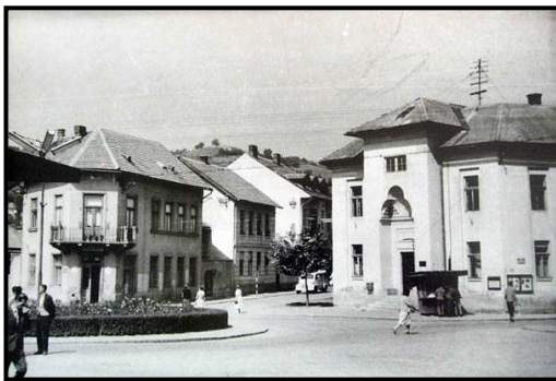
Abb. 15: Das alte Gebäude „Behram-beg Medrese“ in Tuzla 327
