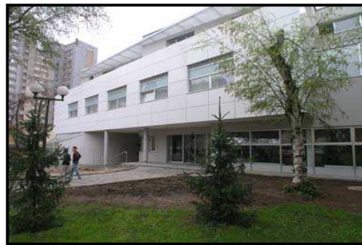
Abb. 16: Das neue Gebäude „Behram-beg Medrese“ in Tuzla 328
