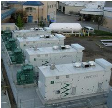
Abbildung 21: Brennstoffzellenkraftwerk in Kalifornien
