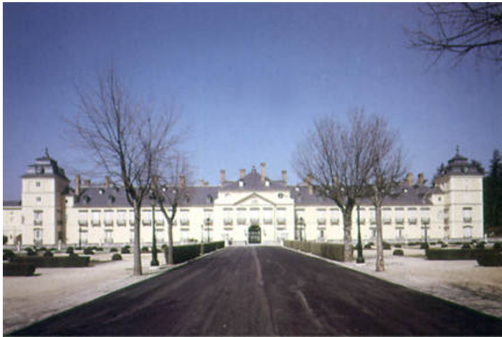
Abb. 4 Fassade des Palastes El Pardo
