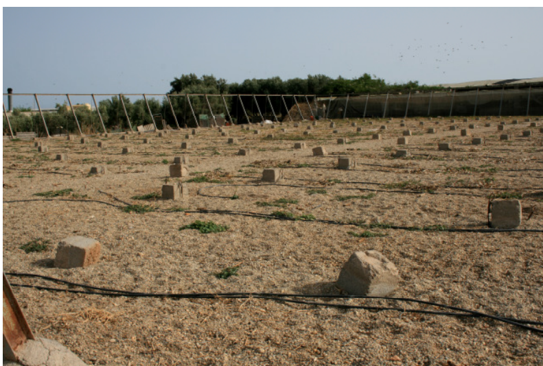
Abbildung 12: Fundament eines typischen Gewächshauses in Almería, Spanien. Foto: Michaela C Theurl
