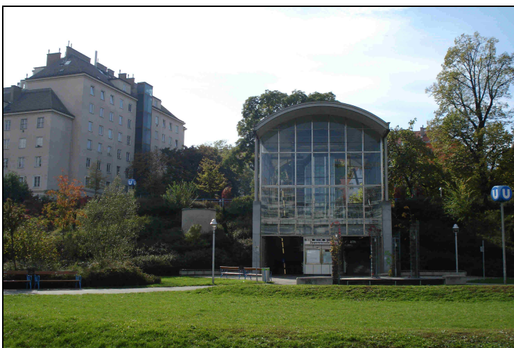
Station Zippererstraße – Hyblerpark (Blick Richtung Süden)
