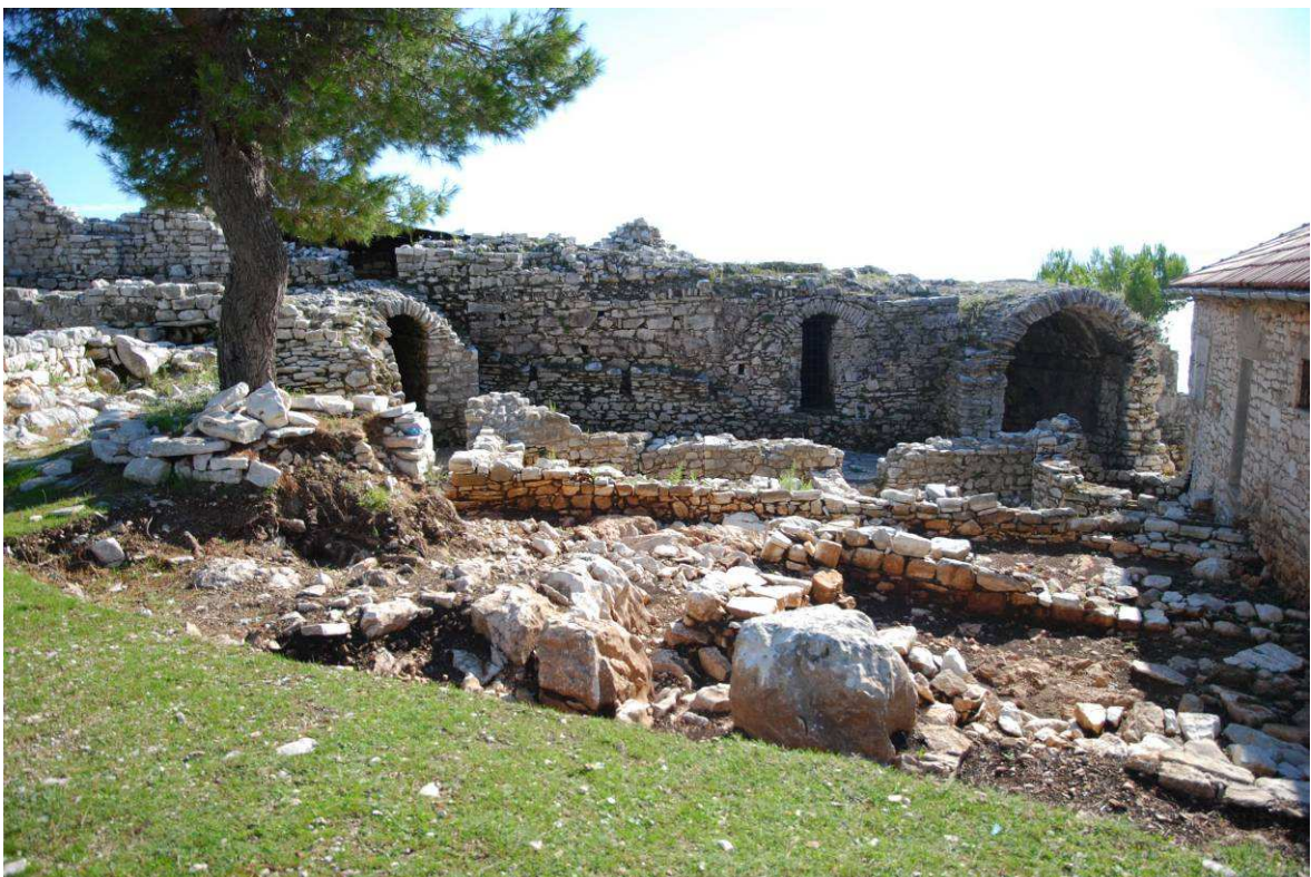
Abb. 58: Bereich der Krypta.
