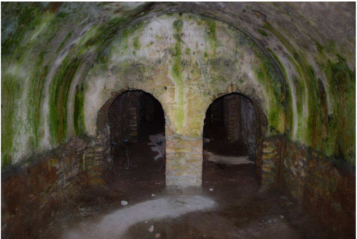
Abb. 45: Einblick in den westlichen Zugang zur Krypta an der Nordseite der Kirche.
