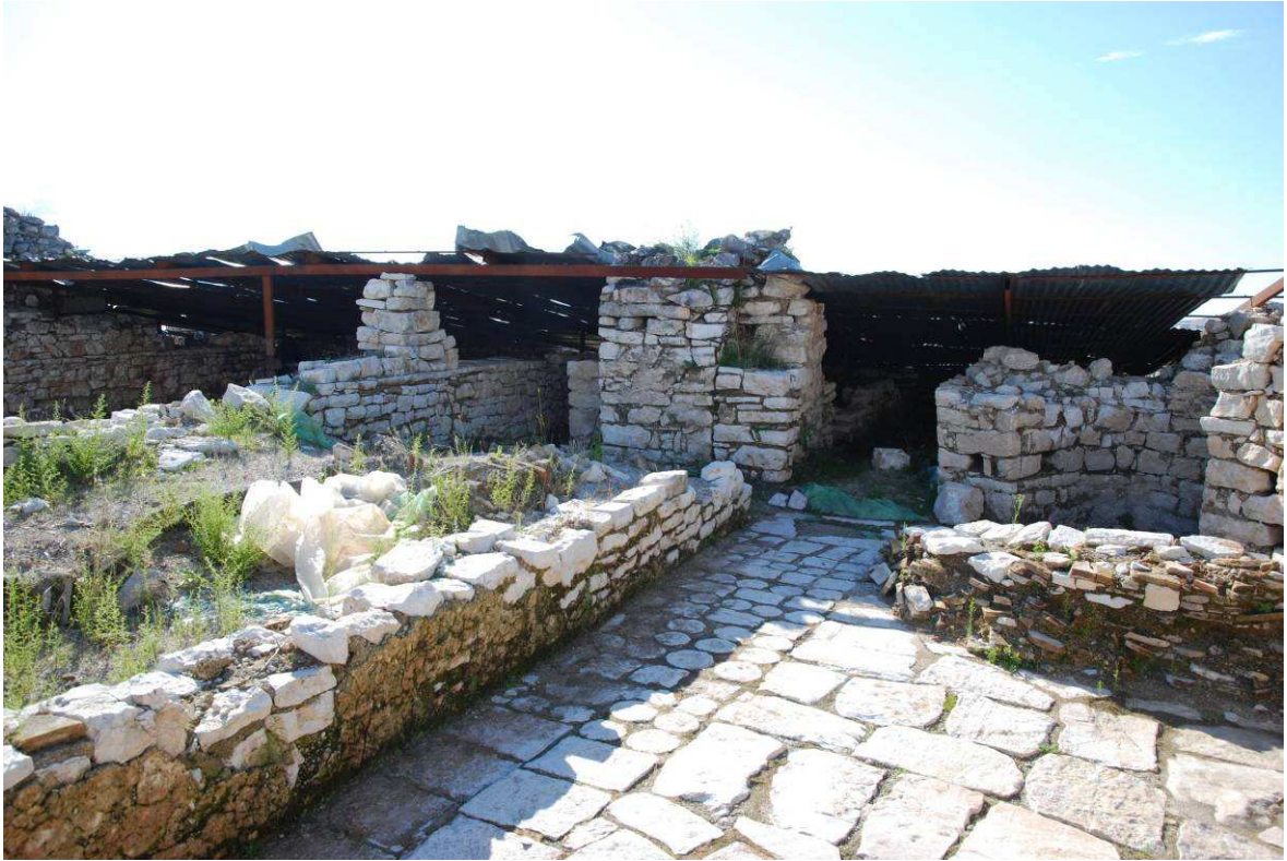
Abb. 21: Situation der Mauern, die das Hauptschiff von den Konchen trennen.
