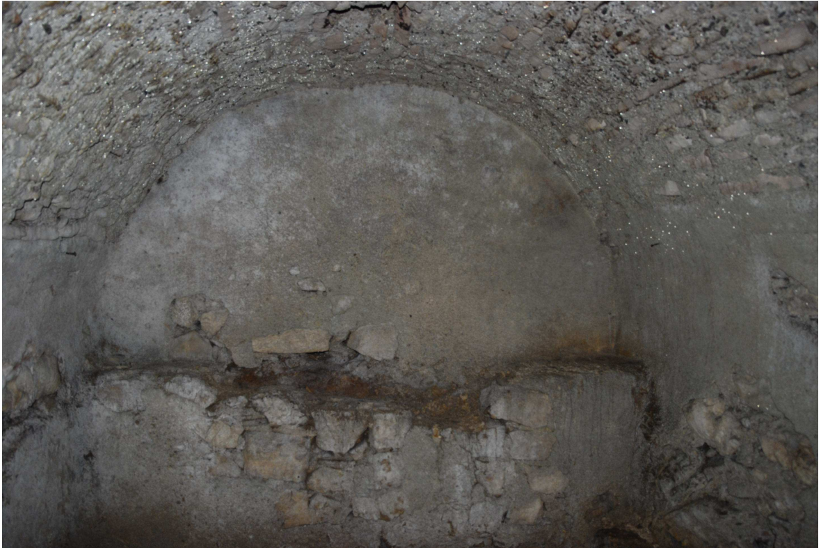
Abb. 29: Eingangsbereich zu Raum 2 in der Krypta, Blickrichtung Osten.
