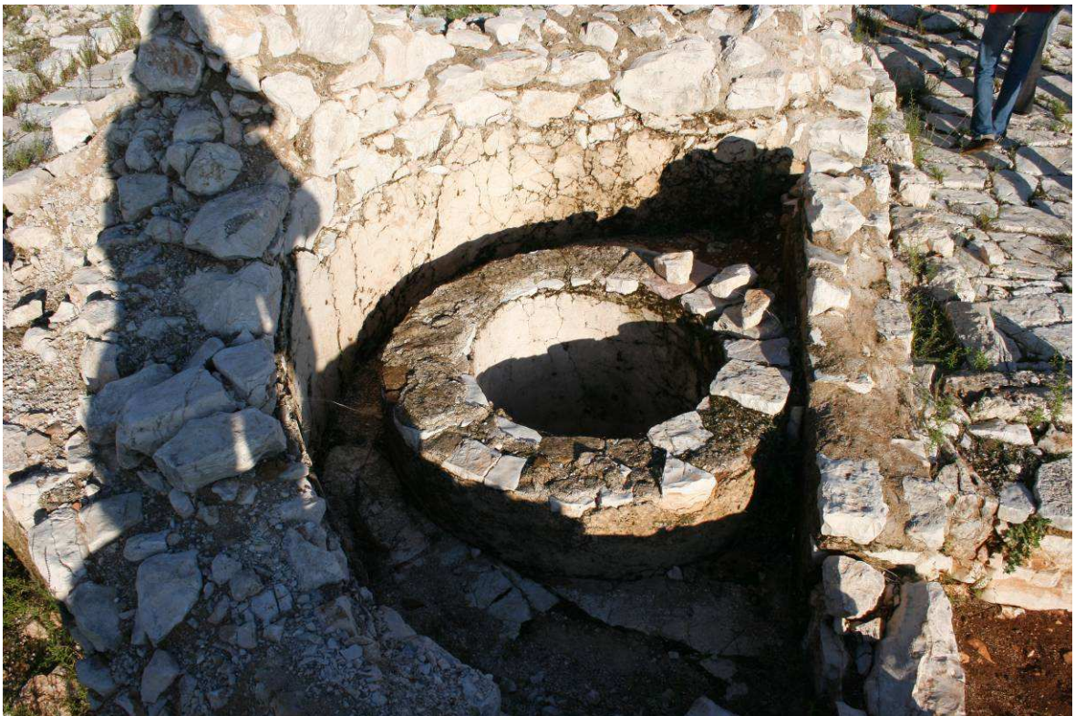
Abb. 62: In die Nordwand konstruierter Schacht.
