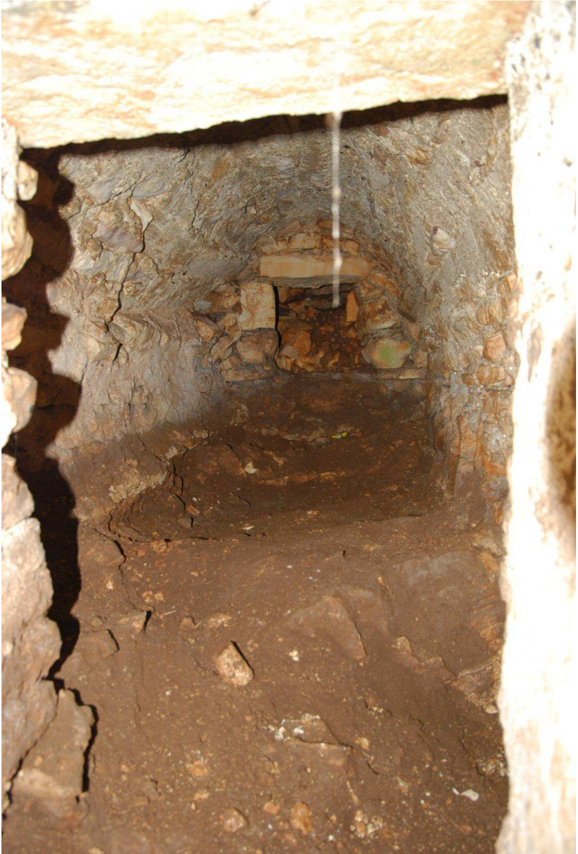
Abb. 40: Einblick in das südlich liegende Fenster des Sanktuariums.
