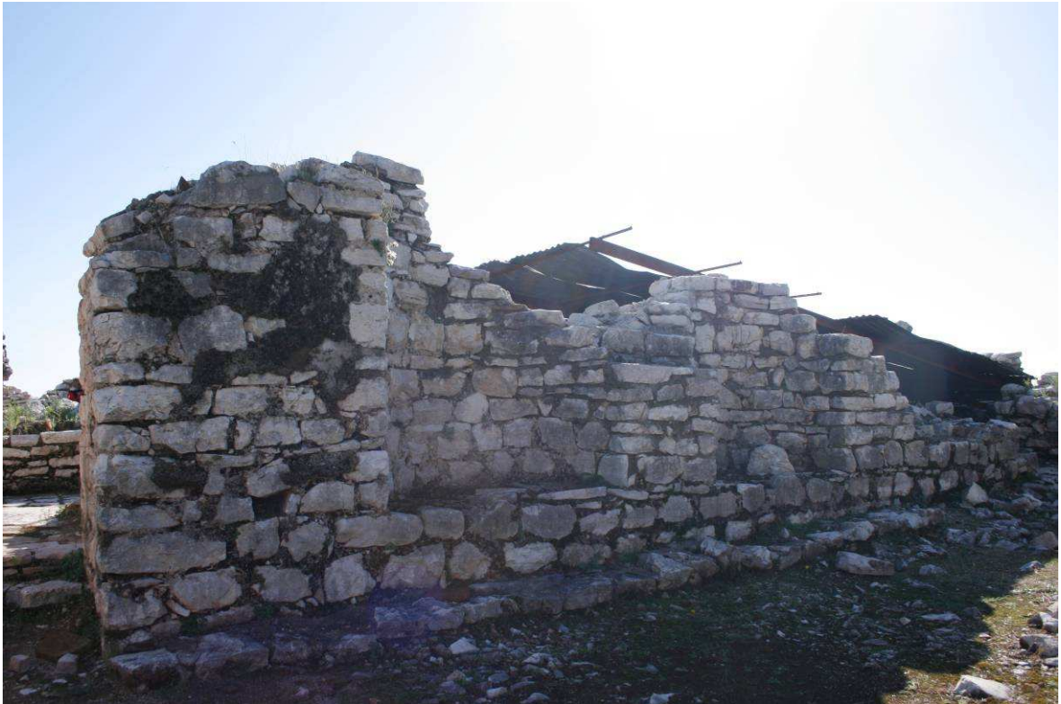
Abb. 6: Westlicher Bereich der aufragenden Außenmauer an der Nordwand.
