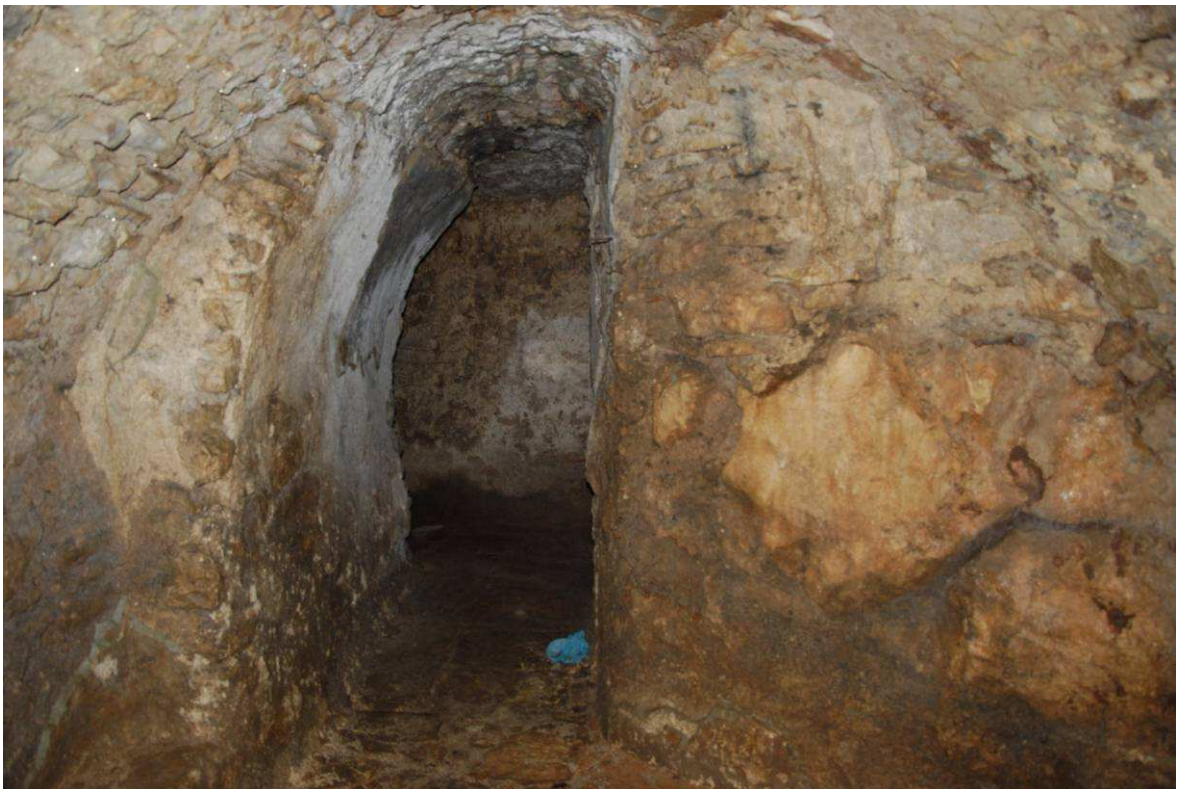
Abb. 37: Eingangsbereich mit Wandvorlage des Raumes 6, Blickrichtung Westen.
