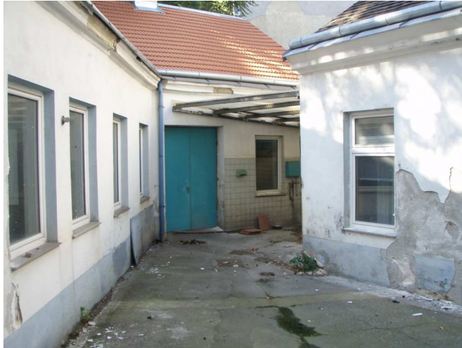
Abb.7: Rauchfangkehrergasse 46, leerstehend und intakt
