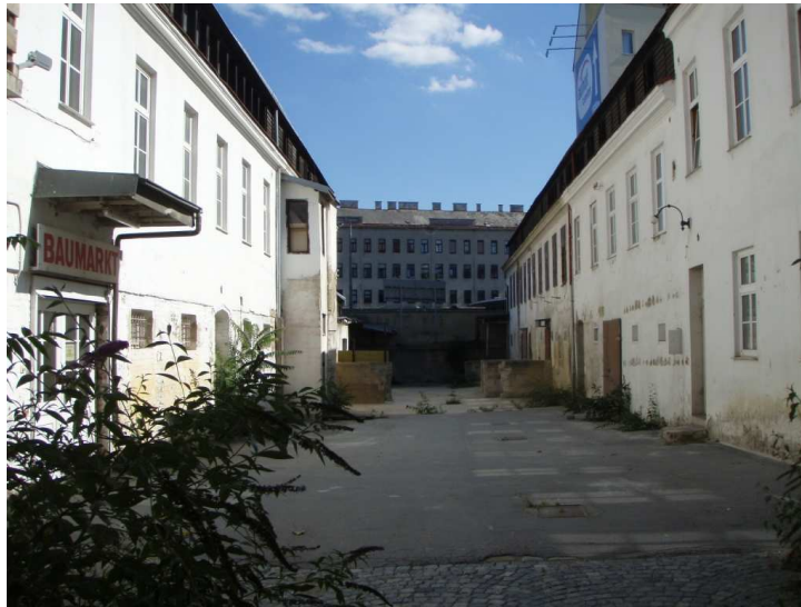
Abb.5: Diefenbachgasse 7, ehem. Baustoffhandel, leerstehend und intakt 40
