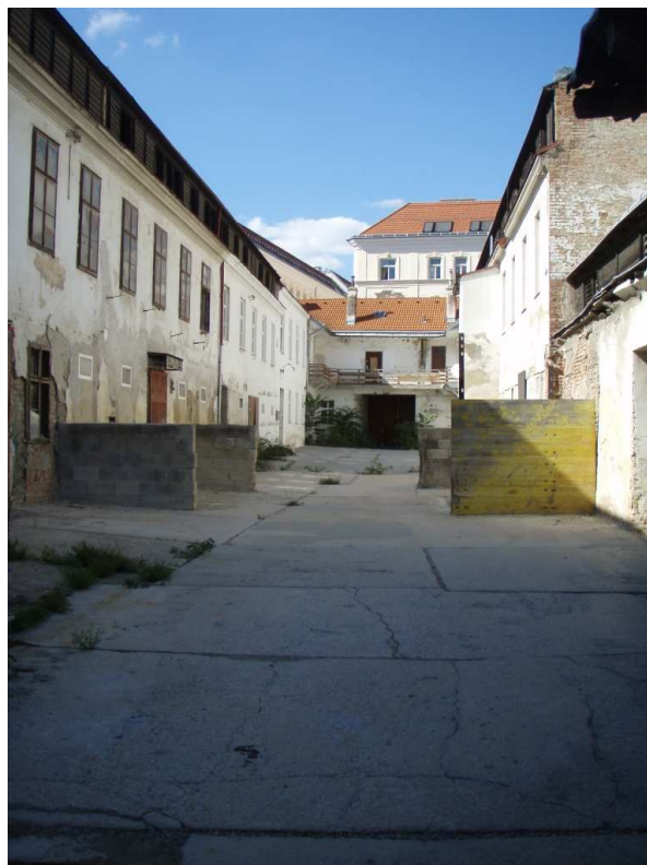
Abb.6: Diefenbachgasse 7, ehem. Baustoffhandel, leerstehend und intakt
