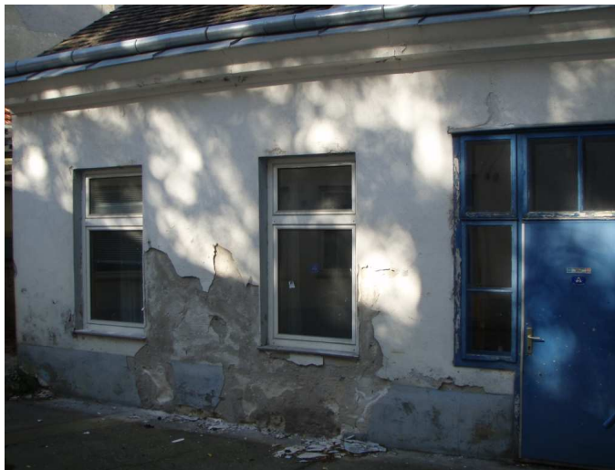
Abb.8: Rauchfangkehrergasse 46, leerstehend und intakt
