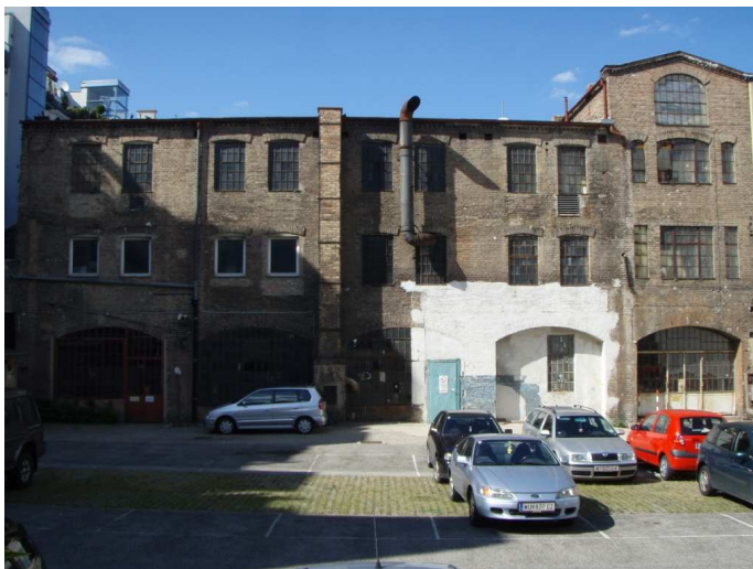
Abb.9: Diefenbachgasse 2, genutzt als Lager/Werkstätte
