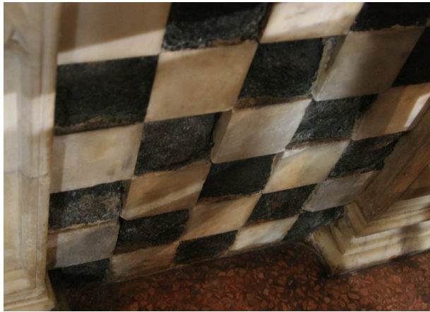
Abbildung 23 Verwitterung des schwarzen Marmors auf der Südseite
