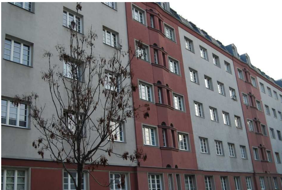
Abb. 179 Heizmann-Hof, gassenseitige Fassade mit Erkern, rot-weißer Farbgliederung und abgerundetem Mansardendach
