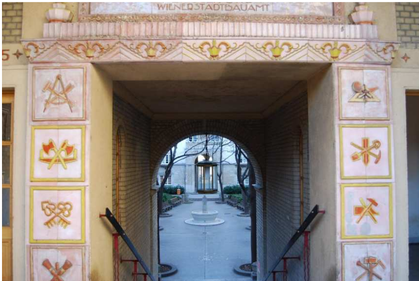
Abb. 83 Reumann-Hof, Durchgang zum Seitenhof
