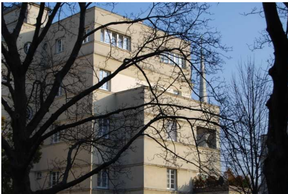
Abb. 221 Karl-Seitz-Hof, Gestaltung Rück- und Hofseiten: kleinteiligere Baugruppen
