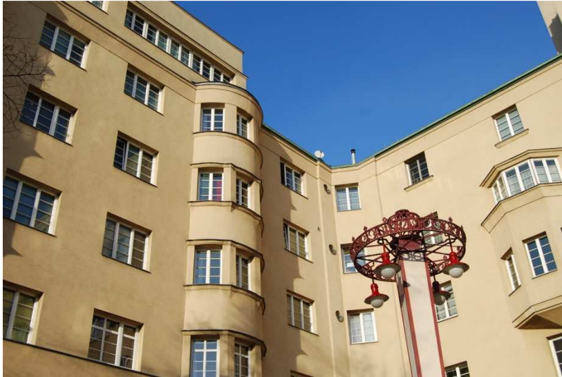
Abb. 128 Reumann-Hof, siebengeschosige Seitenflügel
