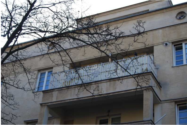
Abb. 219 Karl-Seitz-Hof, Gestaltung Rück- und Hofseiten: kleinteiligere Baugruppen
