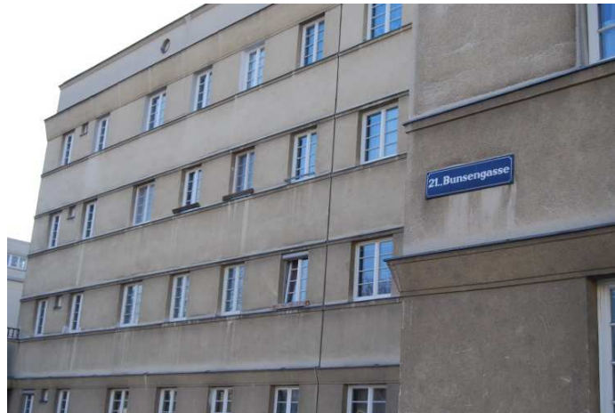
Abb. 226 ebenso, Fassade Bunsengasse
