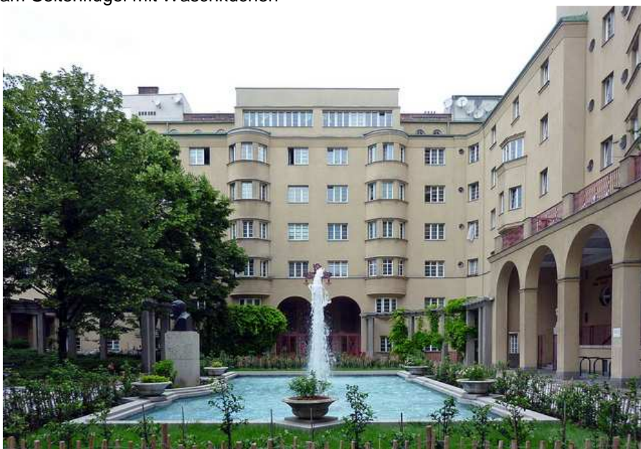
Abb. 140 Reumann-Hof, Ehrenhof mit Gartenanlage, Wasserbassin und Springbrunnen
