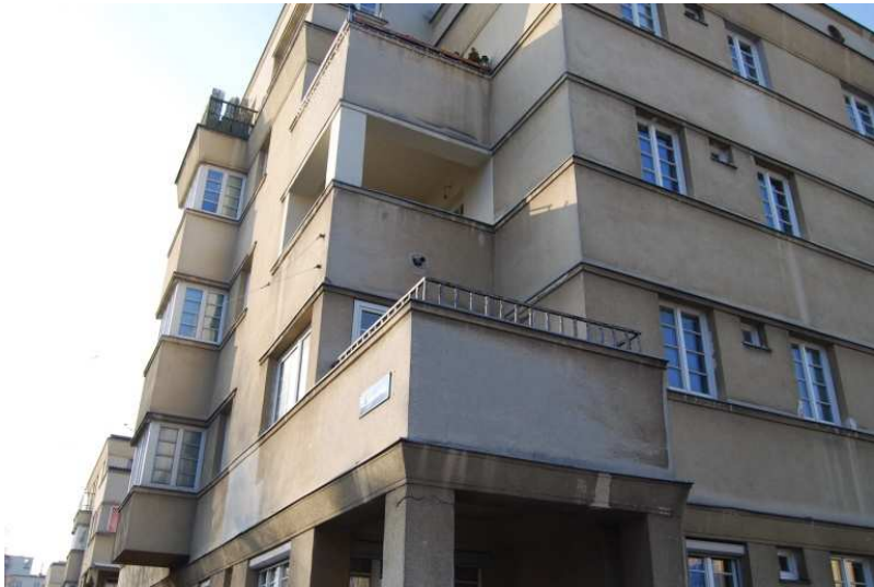
Abb. 220 Karl-Seitz-Hof, Gestaltung Rück- und Hofseiten: kleinteiligere Baugruppen
