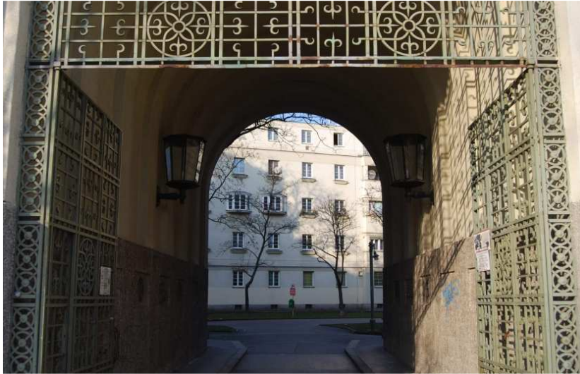
Abb. 264 Karl-Seitz-Hof, Beleuchtung Durchgang
