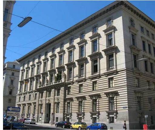
Abb. 64 Wohnhaus Stadiongasse Nr. 6-8
