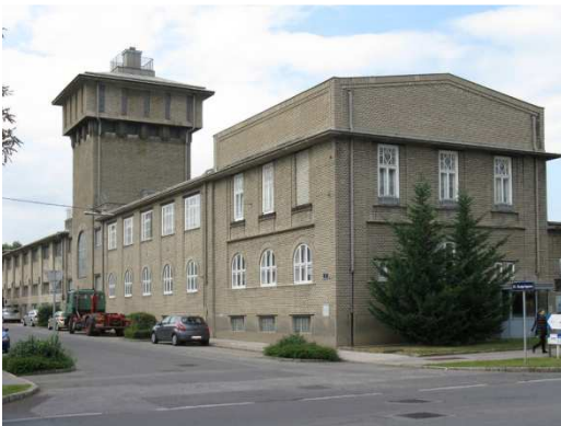
Abb. 201 ehemalige Maschinen-, Kisten- und Holzwarenfabrik Koffmahn, heute Sargfabrik 1913-16
