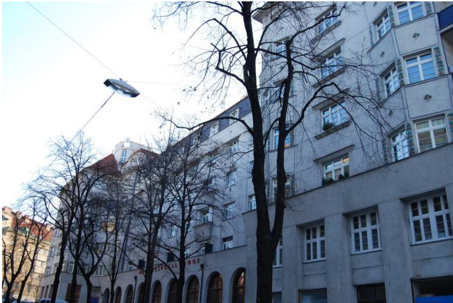
Abb. 113 Metzleinstaler-Hof, Fassade Richtung Siebenbrunnenfeldgasse
