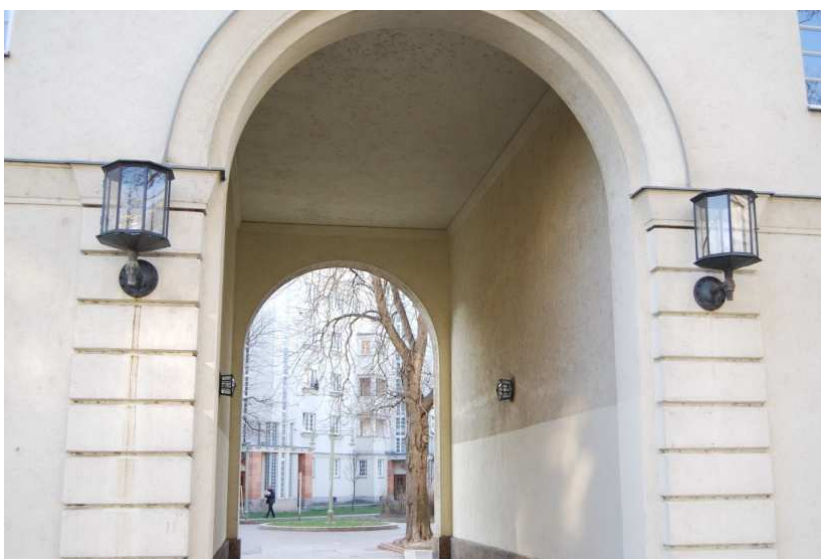
Abb. 266 Karl-Seitz-Hof, Beleuchtung Durchgang
