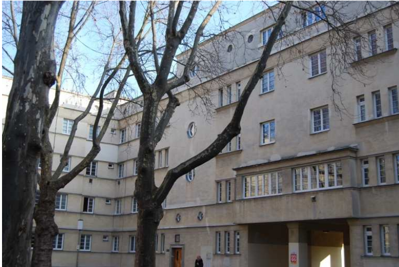
Abb. 212 Karl-Seitz-Hof, Bullaugen- und Rundfenster an den Seitenflügeln und Mittelpartien
