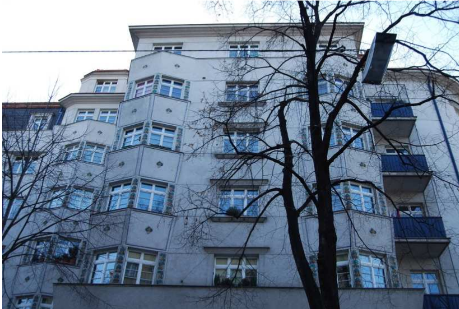
Abb. 112 Metzleinstaler-Hof, Erker Richtung Straße
