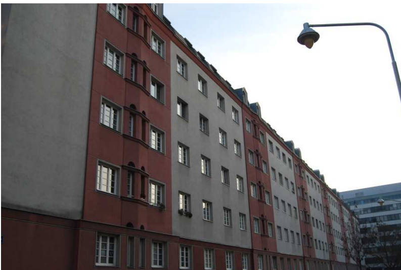
Abb. 175 Heizmann-Hof, langgestreckte Fassade Richtung Ofnergasse
