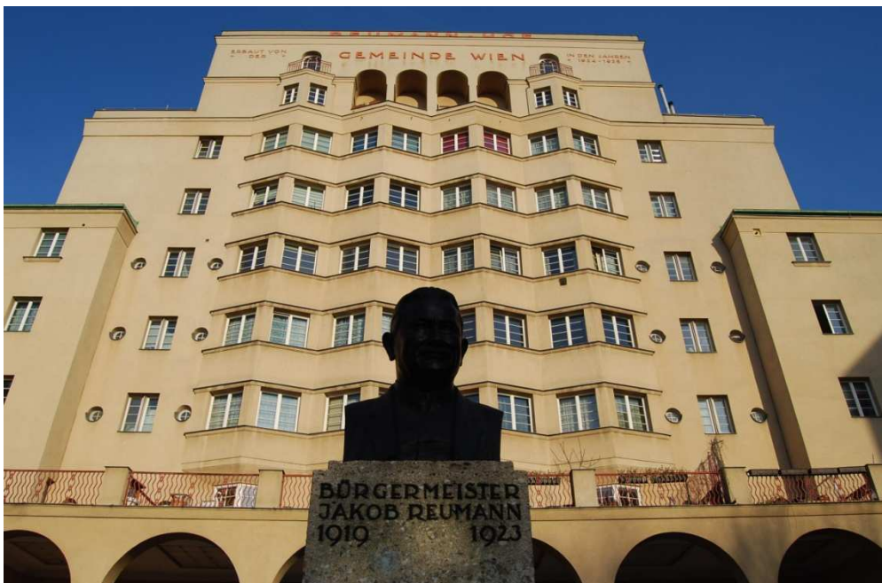
Abb. 143 Reumann-Hof, harmonikaartig gefaltetes Mittelfeld mit Blendfensterarkaden im Dachgeschoß, Dachzonenlösung mit heraustretenden Erkerfenstern und Loggien
