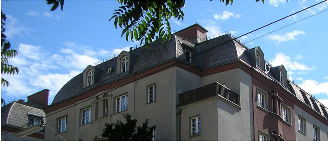
Abb. 180 Heizmann-Hof, oberer Abschluss: abgerundete Mansardendachlösung m. kreisförmigen Dachluken
