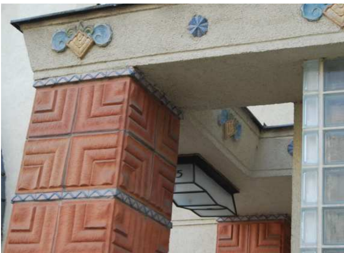
Abb. 263 Karl-Seitz-Hof, Beleuchtung Stiegeneingang
