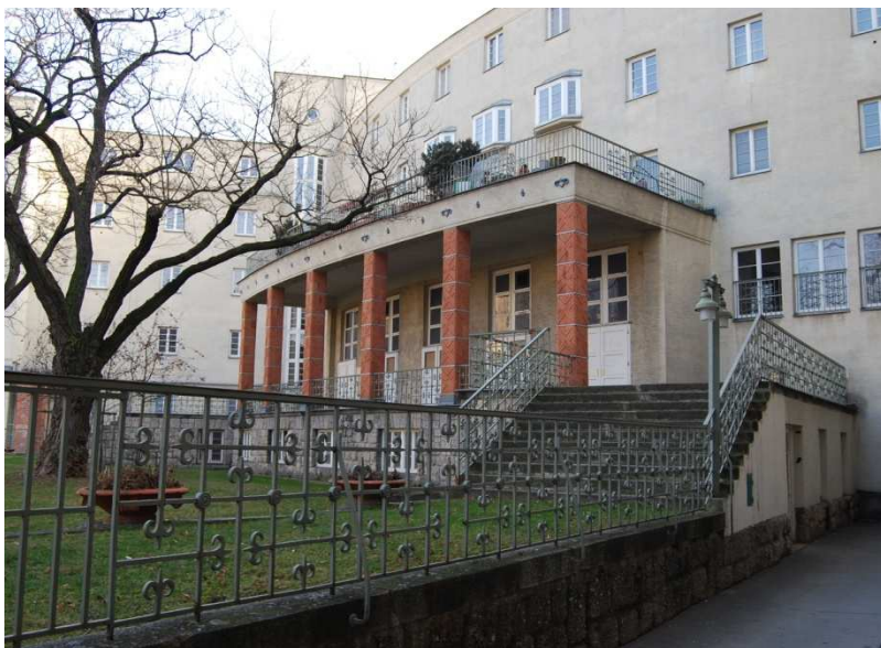
Abb. 204 Karl-Seitz-Hof, hofseitig gelagerte Teil mit feierlicher Terrasse
