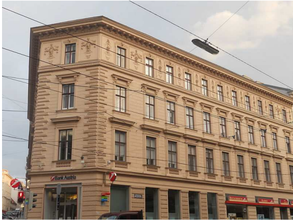
Abb. 63 Wohnhaus Wiedner Hauptstraße Nr. 65
