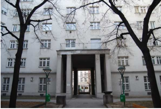
Abb. 161 Portal, Ansicht vom Hof aus
