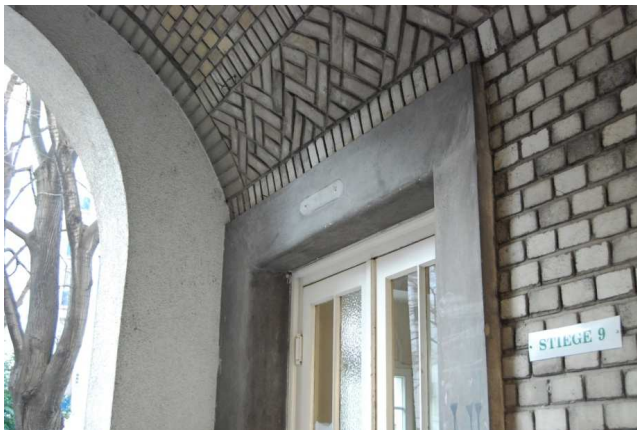
Abb. 47 Metzleinstaler-Hof, zweiter Bauteil, Stiegenzüge von innen
