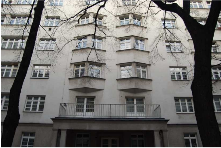
Abb. 156 Lassalle-Hof, Fassade innen
