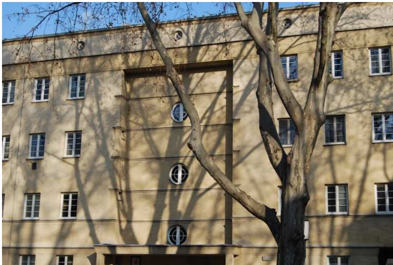
Abb. 213 Karl-Seitz-Hof, Bullaugen- und Rundfenster an den Seitenflügeln und Mittelpartien
