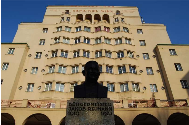
Abb. 132 Reumann-Hof, Dreieranordnung in der Dachzone
