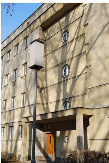
Abb. 214 Karl-Seitz-Hof, Bullaugen- und Rundfenster an den Seitenflügeln und Mittelpartien
