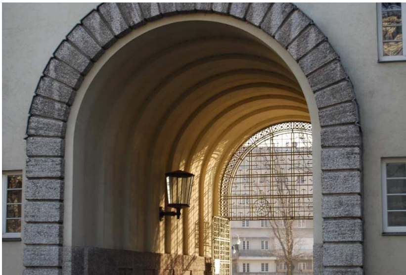
Abb. 265 Karl-Seitz-Hof, Beleuchtung Durchgang
