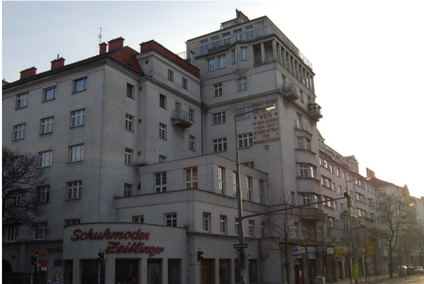
Abb. 150 Lassalle-Hof, auffallend betonter Ecktrakt
