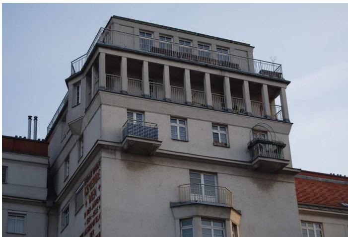
Abb. 154 Lassalle-Hof, Atelieraufbauten, durchlaufendes hohes Fensterband, Blendarkade, hervorspringenden Erker
