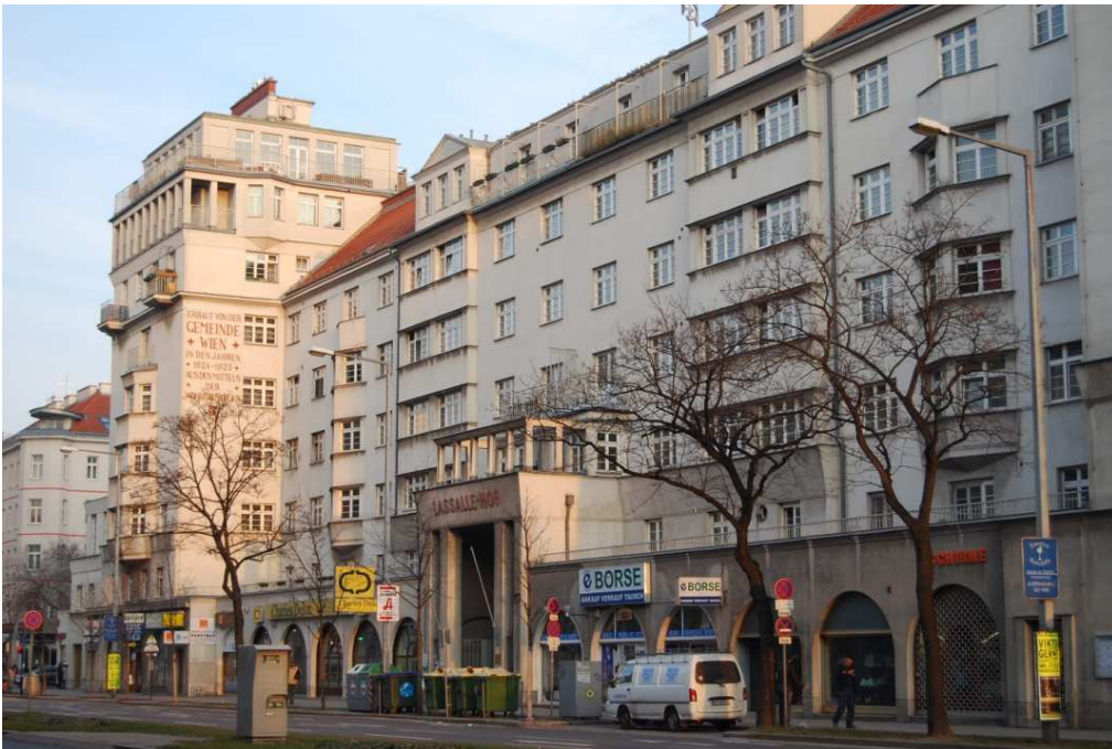
Abb. 163 Lassalle-Hof, Ladenzone mit sockelartigen Rundbögen, Risalite, Erker, schräge Dachzone mit Dreiecksgiebel und Attikamauer
