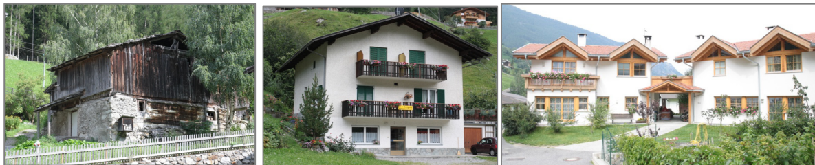
Abbildung 29: Gebäudetypen im Untersuchungsgebiet. Links oben: Ennewasser 157 in alter Bauweise. Rechts oben: Ennewasser 173 in typischer 1960/1970er Bauweise. Unten: Gand 256 und 257 in moderner Bauart (Fotos: Ekrem Canli, 2011)
