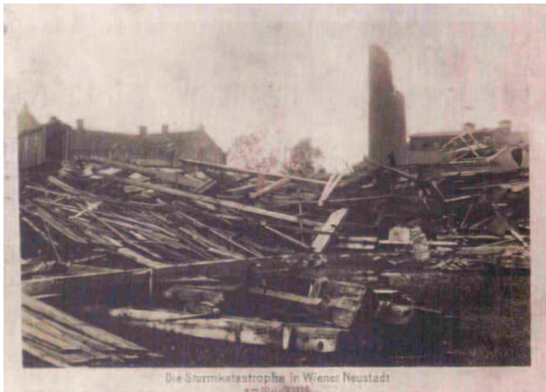
Abbildung 5.48: Schäden an der Lokomotivfabrik [9]
