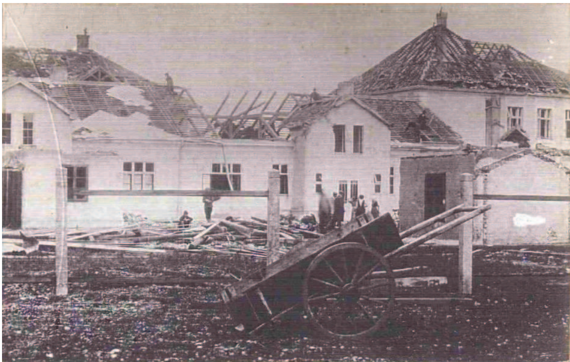
Abbildung 5.50: Schäden (Objekt unbekannt) [9]
