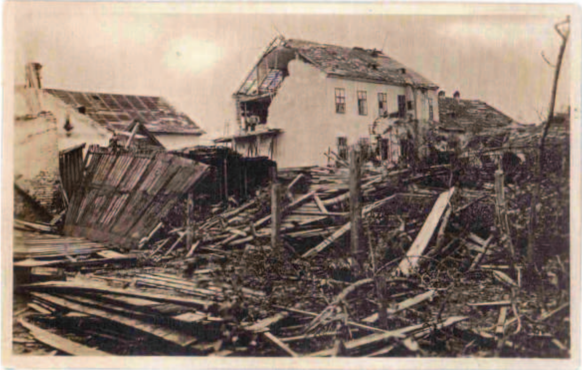
Abbildung 5.49: Schäden in der Wienerstraße-Kreuzgasse [9]
