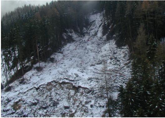
Abbildung 6.5: Mittelteil der Rutschung mit Sekundärabbrüchen (Geologisches Amt Südtirol 2002).
