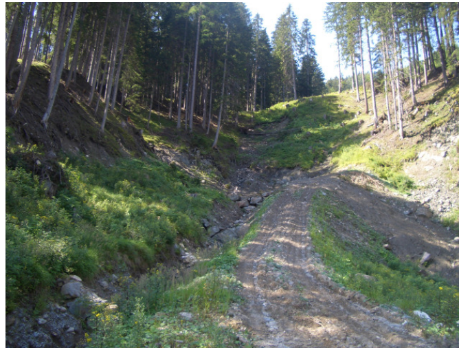
Abbildung 6.16: Erster Teil der gravitativen Massenbewegung, bergwärts (eigenes Foto Juli 2007).
