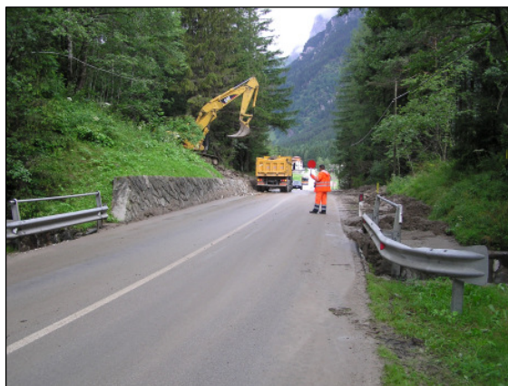
Abb. 6.7: Räumungsarbeiten an der Bundesstraße
