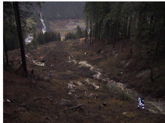
Abbildung 6.4: Oberster, verflachter Teil der Rutschung mit Wasseraustritten (Geologisches Amt Südtirol 2002).
