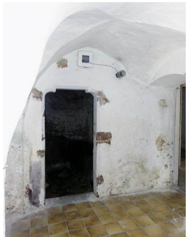
31 Bad Leonfelden, Eingangsbereich zur Kammer mit Schulterbogenportal und abgefastem Gewände (vorne); Eingang zum Spital, ursprüngl. Portal verloren (rechts).
