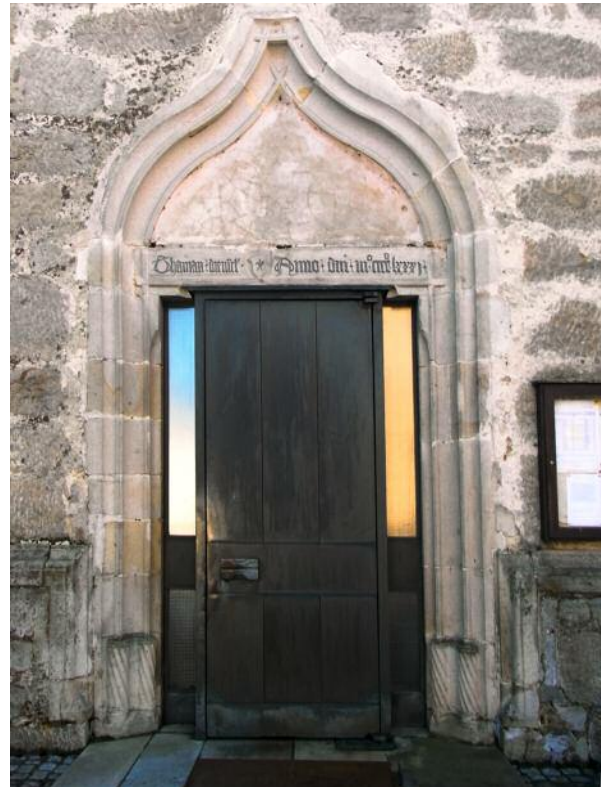
114 Bad Leonfelden, Nordportal der Pfarrkirche mit Eselsbogen und Inschrift: Thaman Dienstl - Meisterzeichen - Anno domini 1483.
