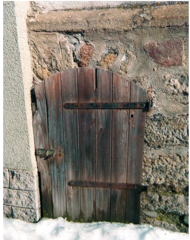
67 Bad Leonfelden, Spitalskirche, Holztürchen in die ‚Raihe‘, integriert in die aus Bruchsteinmauerwerk konstruierte Sockelzone.
