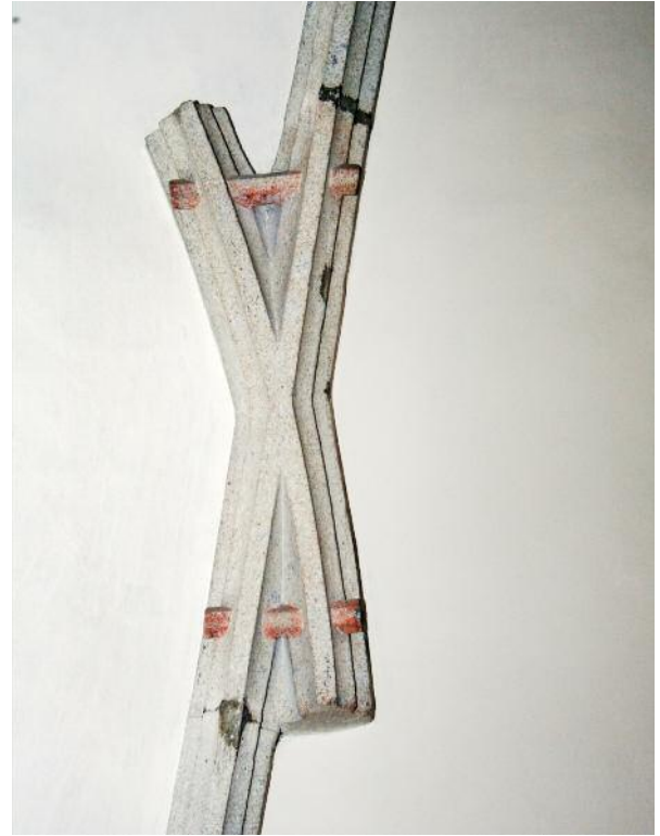
202 Kalsching, Gewölbe, Detail.
