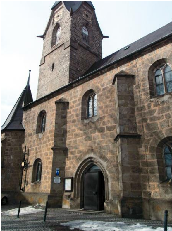
113 Bad Leonfelden, Pfarrkirche Hl. Bartholomäus, Ansicht der Südfassade mit dreieckigen Mauervorlagen und Rundbogenfenstern, Ende 15. Jh.
