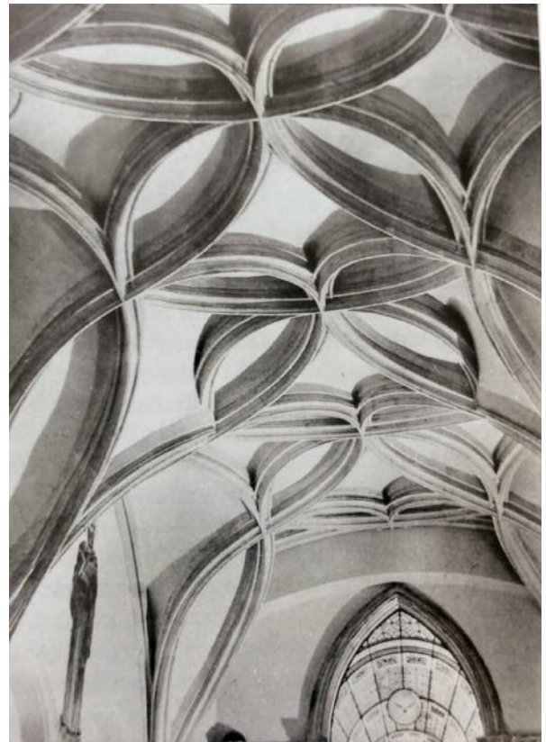
159 Wien, ehem. Niederösterreichisches Landhaus, Durchfahrtshalle, Schlingrippengewölbe, um 1515.
