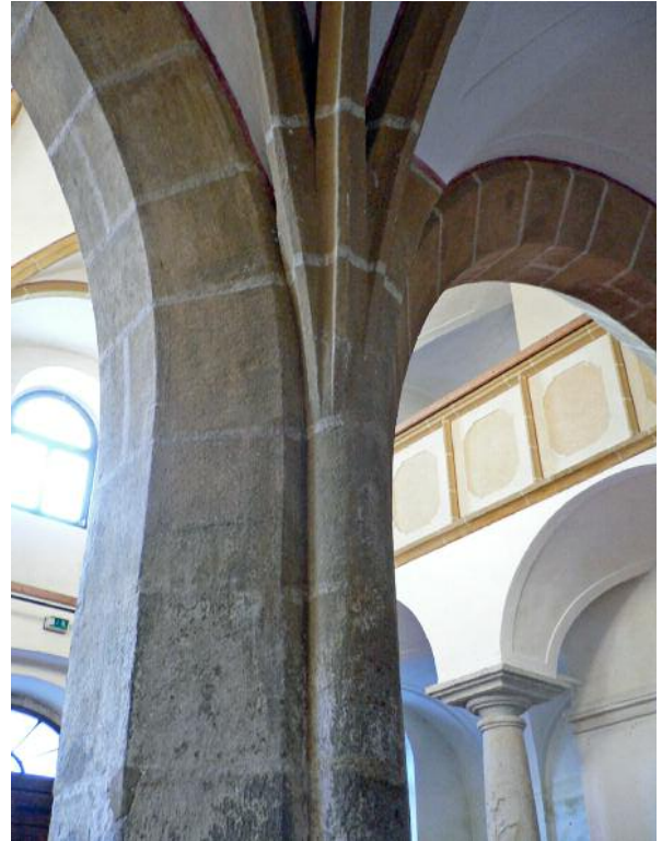
99 Bad Leonfelden, Spitalskirche, Dienst und Gewölbeanfänger mit herauswachsenden Rippen.
