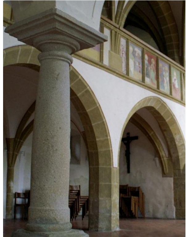
78 Bad Leonfelden, Spitalskirche, Blick von West- zur Nordempore mit achteckigen Pfeilern und rundböigige Arkaden.
