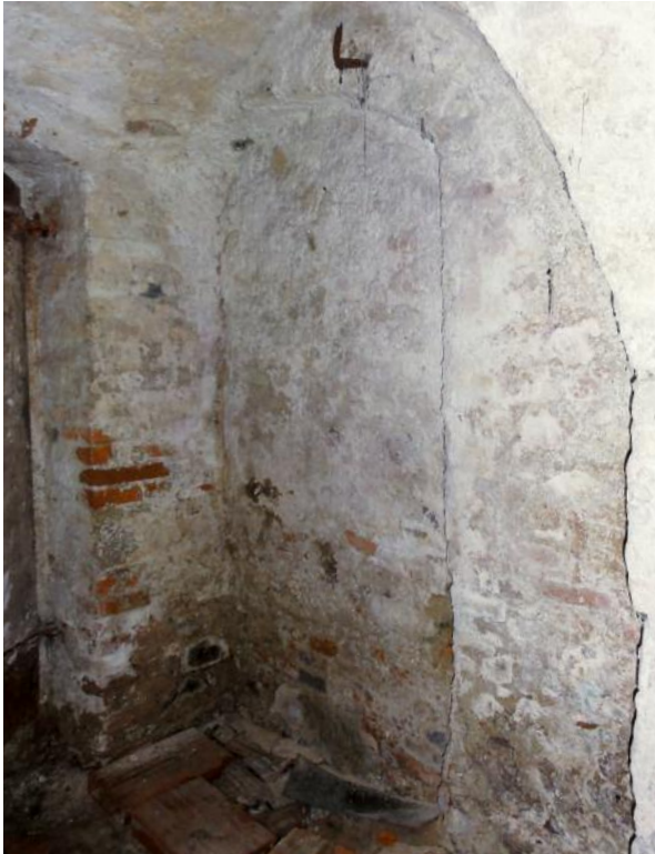
35 Bad Leonfelden, rechts neben der Mauer, zugemauerter Zugang, vermutlich zum ehem. Emporenaufgang.
