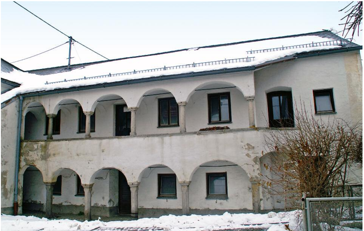
39 Bad Leonfelden, Arkadentrakt mit abgefasten Pfeilern im Erdgeschoß und toskanischen Säulen im Obergeschoß, um 1600.
