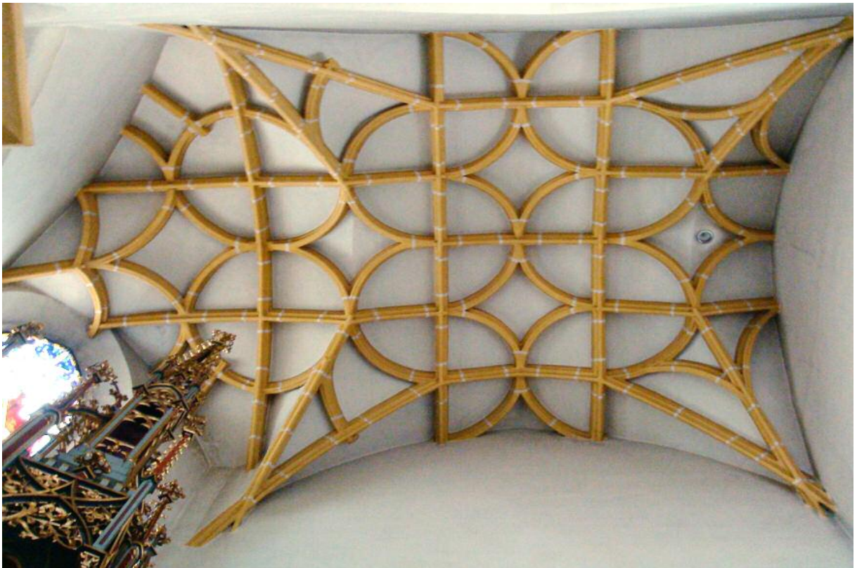
181 Aschbach, Schlingrippengewölbe der Steyrer Viertellade, um 1515.
