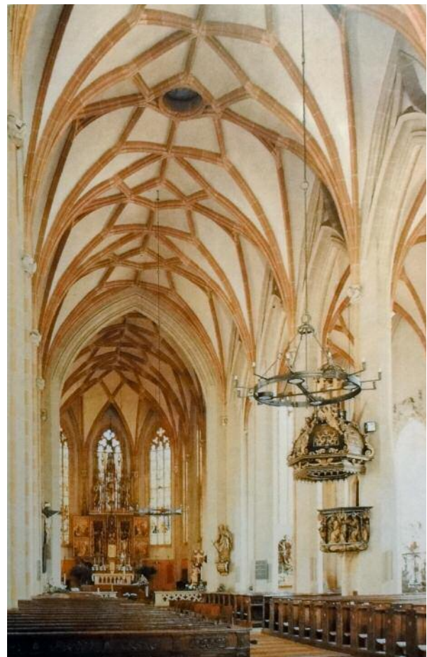
147 Braunau, Stadtpfarrkirche, Einblick ins Langhaus, im Seitenschiff mit Bogenrippengewölbe.
