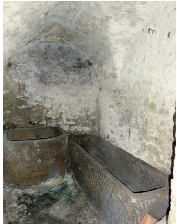
34 Bad Leonfelden, nördliche Kammer mit zwei Granitgrandern, durch den Einbau der Zwischenmauer als separater Raum ausgetrennt.
