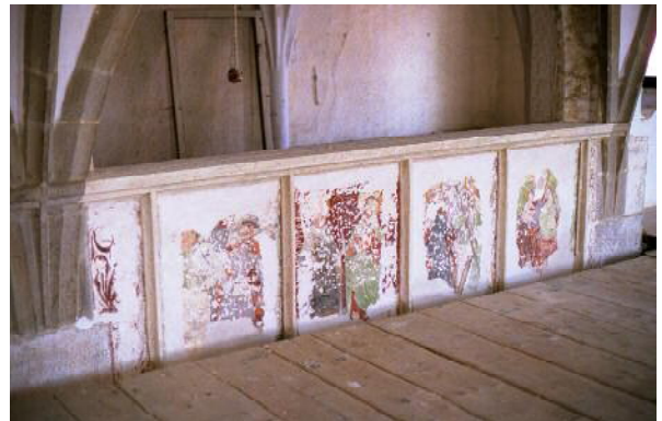
56 Bad Leonfelden, Spitalskirche, a) oben: Detail der nordwestlichen Arkade: Übergang von Stein- zur Ziegelbauweise. b) unten: freigelegte Fresken an der Brüstung der Nordempore.
