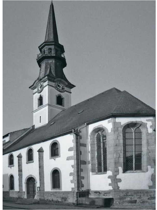
65 Bad Leonfelden, Spitalskirche, Außenansicht der renovierten Kirche von Südosten, 1987.
