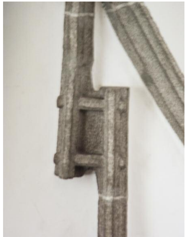
210 St. Martin im Mühlkreis, Pfarrkirche, südliche Kapelle, Detail des Gewölbes.
