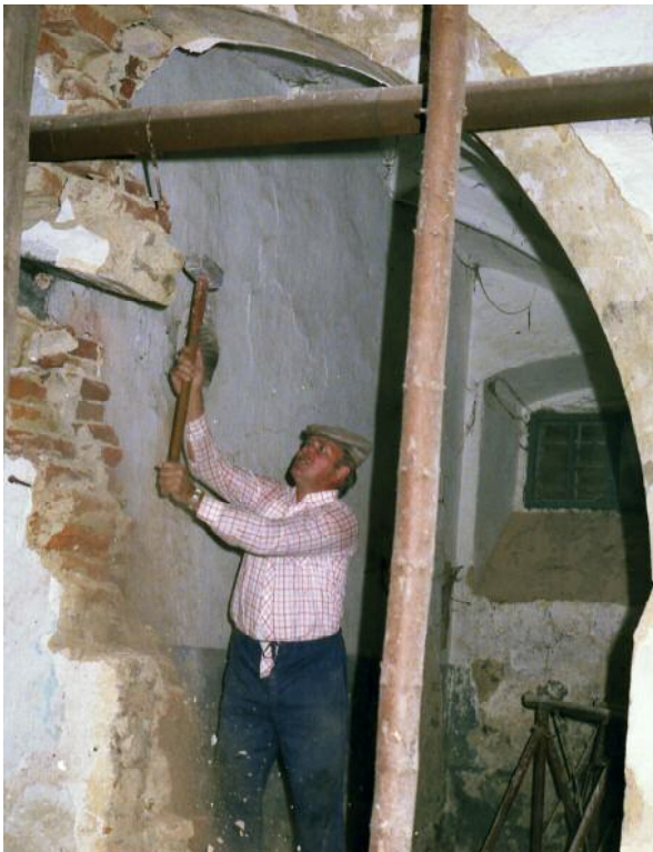
57 Bad Leonfelden, Spitalskirche, Einreißen der Zwischenmauer.
