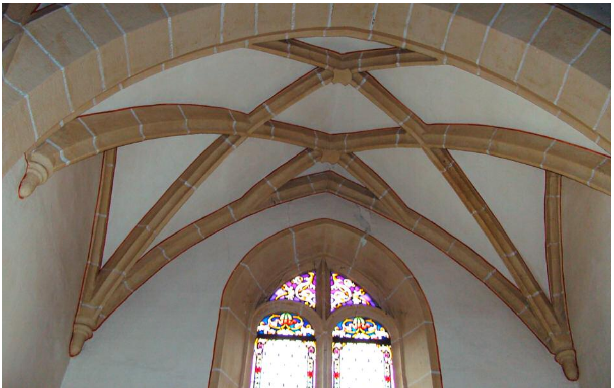
136 Ottensheim, Pfarrkirche, Detail vom Gewölbe einer Einsatzkapelle mit runden Konsolen und tellerförmigen Übergang zu den einfach profilierten birnstabförmigen Rippen, im Jochmittelpunkt werden die überschneidenden Rippen von einem Meisterzeichen geschmückt, gleiche Farbgebung der Rippen und Einrahmung wie in der Spitalskirche.
