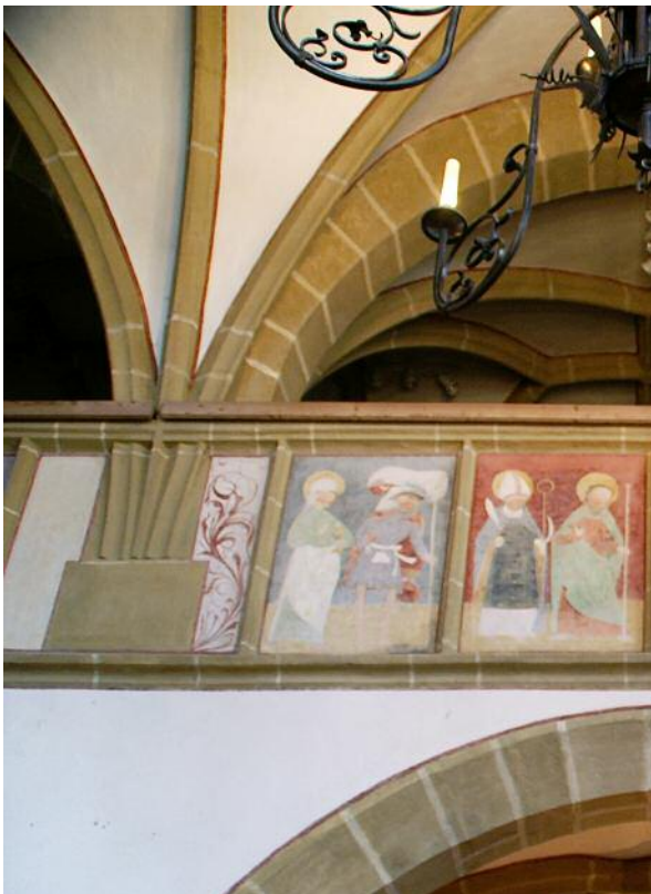
93 Bad Leonfelden, Spitalskirche, Arkadenpfeiler im Emporengeschoß mit herauswachsenden Rippen.
