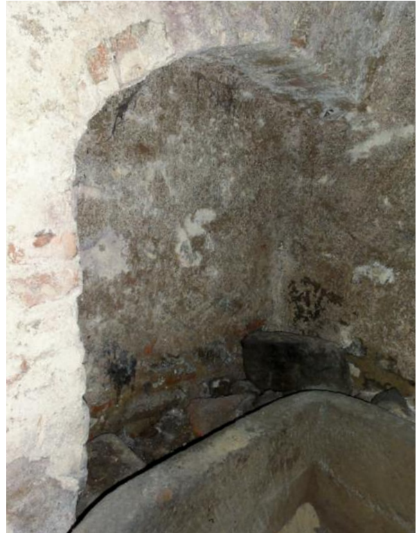
36 Bad Leonfelden, rechts neben dem zugemauerten Portal befindet sich eine kleine funktionslose Nische.
