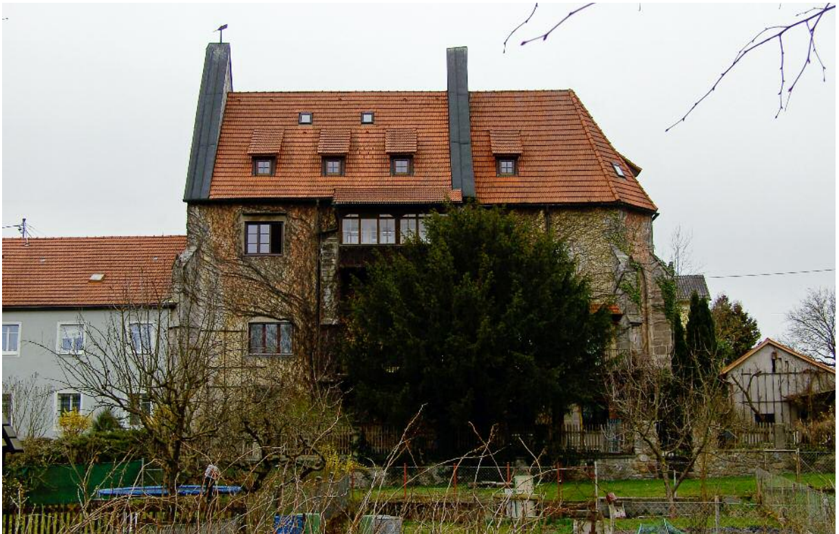
5 Ottensheim, ehem. Bürgerspitalskomplex, Bürgerspital und Spitalskirche sind heute Wohnhäuser.
