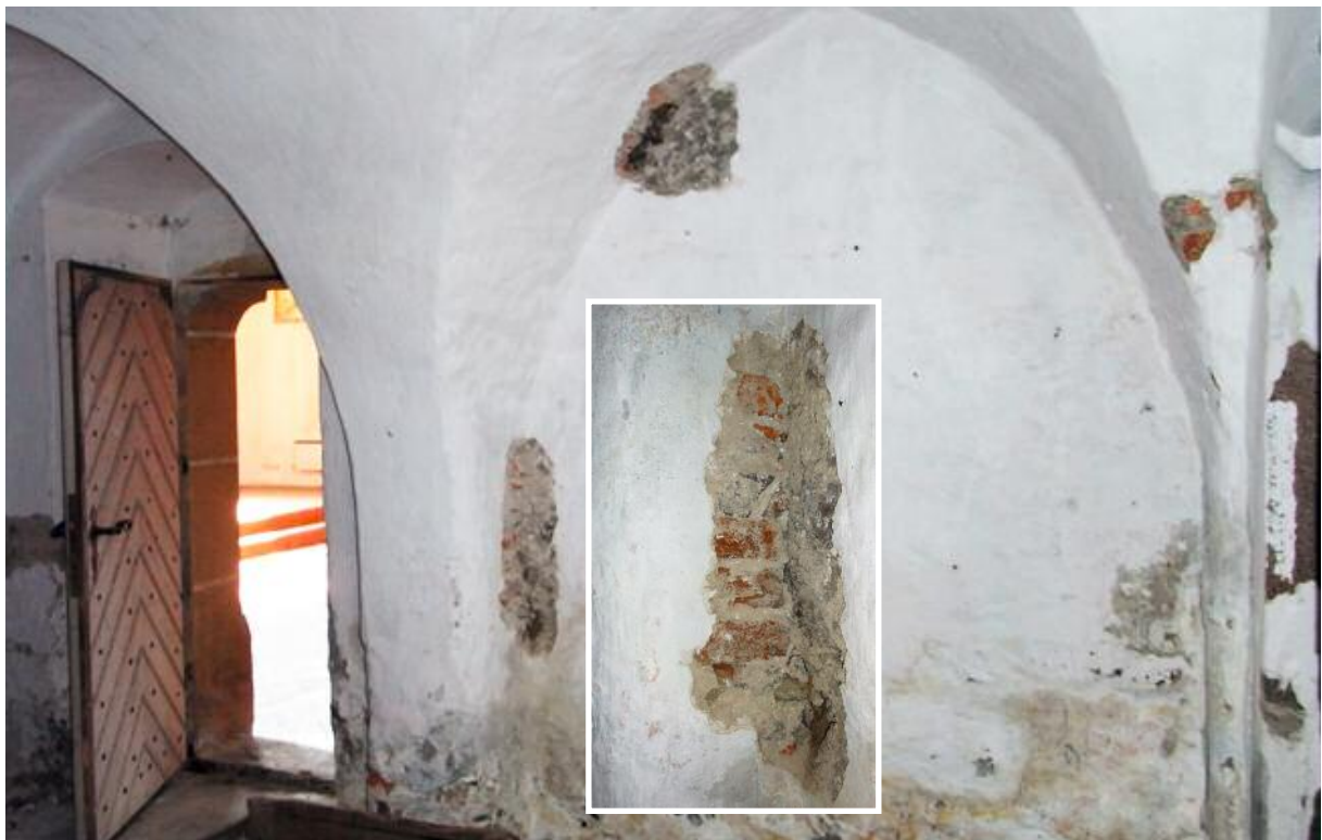
29 Bad Leonfelden, a) Fletz mit Gewölbeträger aus Ziegeln, an der Außenwand der Spitalskirche, die noch aus Bruchsteinmauerwerk besteht; b) Detail von der vom Putz befreiten Mauer.
