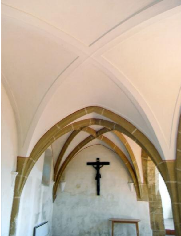
98 Bad Leonfelden, Spitalskirche, Unterwölbung der Nordempore mit Parallelrippengewölbe.
