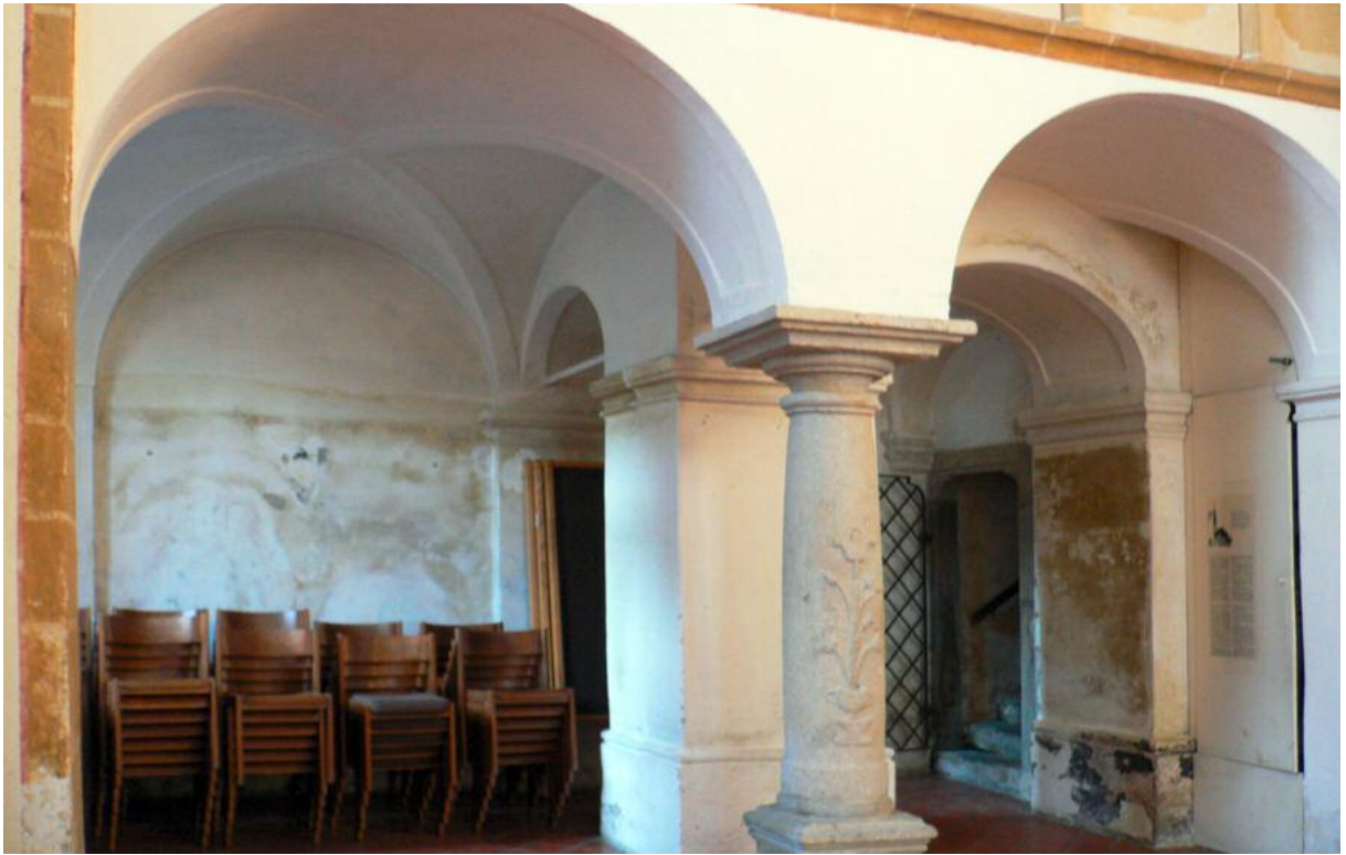
81 Bad Leonfelden, Spitalskirche, barocke Unterwölbung der Westempore mit Kreuzgratgewölbe und stuckatierten Bändern; vorne: toskanische Säule mit Lilienmotiv, zwischen Turmfundament Treppenaufgang zur Empore mit der Jahreszahl 1724.
