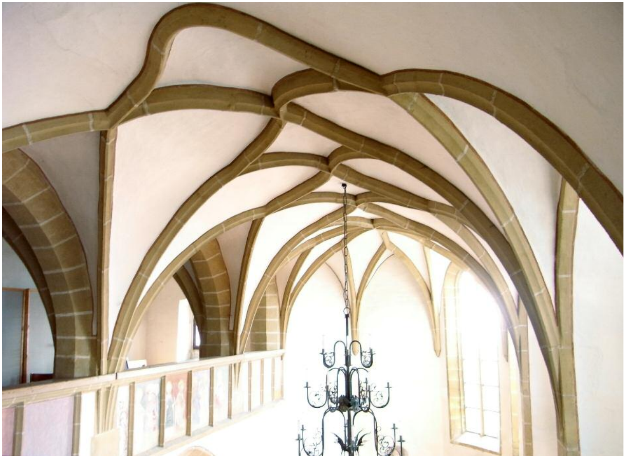
95 Bad Leonfelden, Spitalskirche, Gewölbeeinblick von der Empore in Richtung Apsis.
