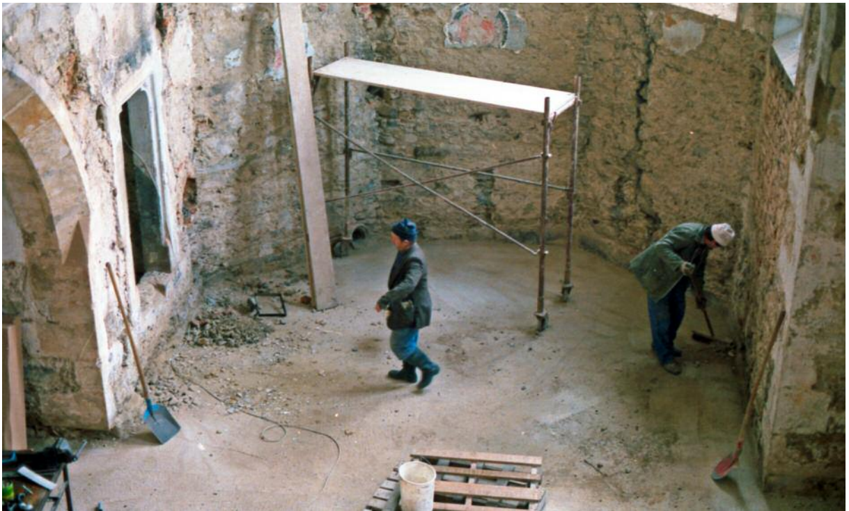
62 Bad Leonfelden, Spitalskirche, Einblick in den 5/8-Chorpolygon, Bruchsteinmauerwerk mit steinernen spätgotischem Sakristeiportal, rechts davon befand sich offenbar eine Sakramentsnische. Spärliche Putzreste verdeutlichen das Ausmaß des zerstörten Chorfreskenzyklus. In der Apsismitte konnte das Freskenrondo vom Hl. Petrus mit Schlüssel gerettet werden.
