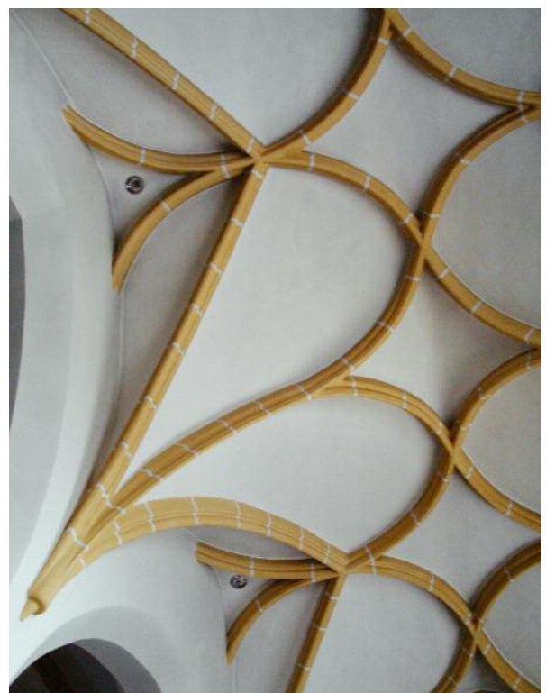
179 Aschbach, Detail des Bogenrippengewölbes vom südlichen Seitenschiff, um 1515.
