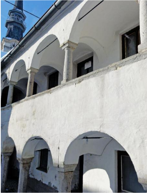
42 Bad Leonfelden, Detail, Arkadentrakt mit böhmischem Kappengewölbe mit Gurten, abgefasten Granitpfeilern und toskanischen Säulen, um 1600.
