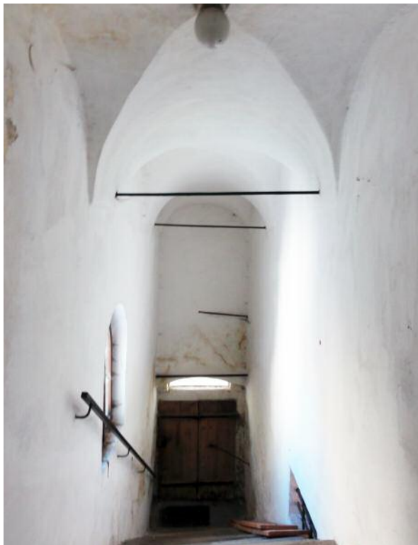
37 Bad Leonfelden, Blick ins barocke Stiegenhaus mit Rundbogenfenster, Steintreppen und Kreuzgratgewölbe.
