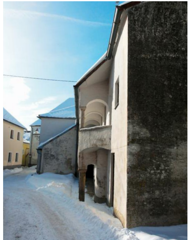
41 Bad Leonfelden, Ansicht des Bürgerspitalskomplexes von Norden; nach dem Arkadentrakt wurde ein Gebäudeteil in jüngster Zeit dazugefügt.
