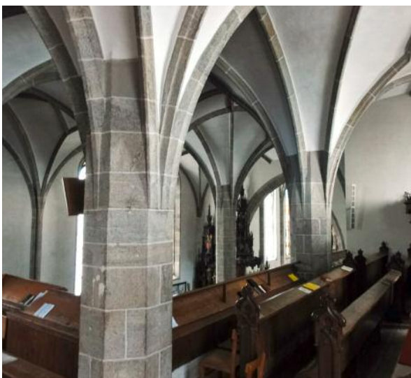
125 Gramastetten, Pfarrkirche, Gewölberippen wachsen aus dem achteckigen Pfeiler empor.
