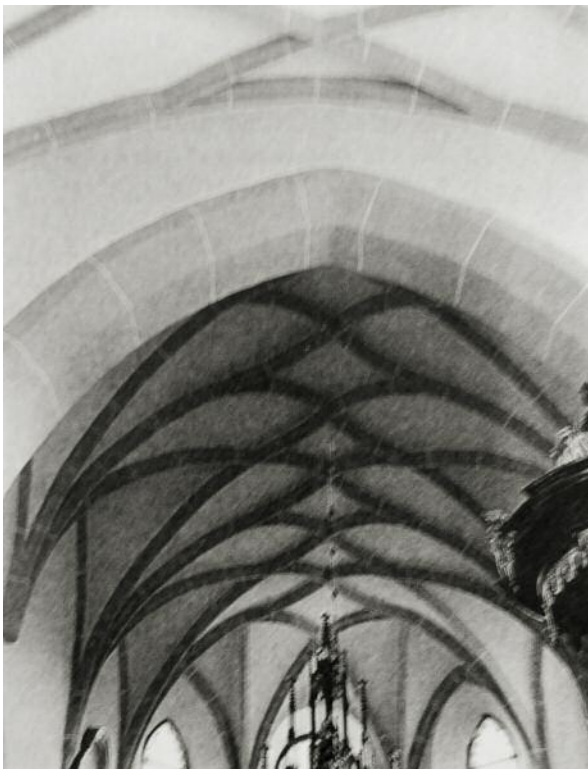
178 Obergrünburg, Bogenrippengewölbe mit sphärischen Rauten im Chorpolygon.
