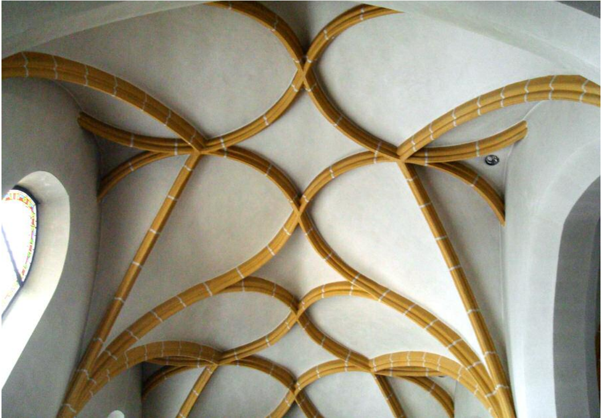
180 Aschbach, Bogenrippengewölbe im Seitenschiff, um 1515.
