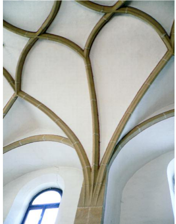
92 Bad Leonfelden, Spitalskirche, Wandpfeiler mit herauswachsenden profilierten birnstabförmigen Gewölberippen.
