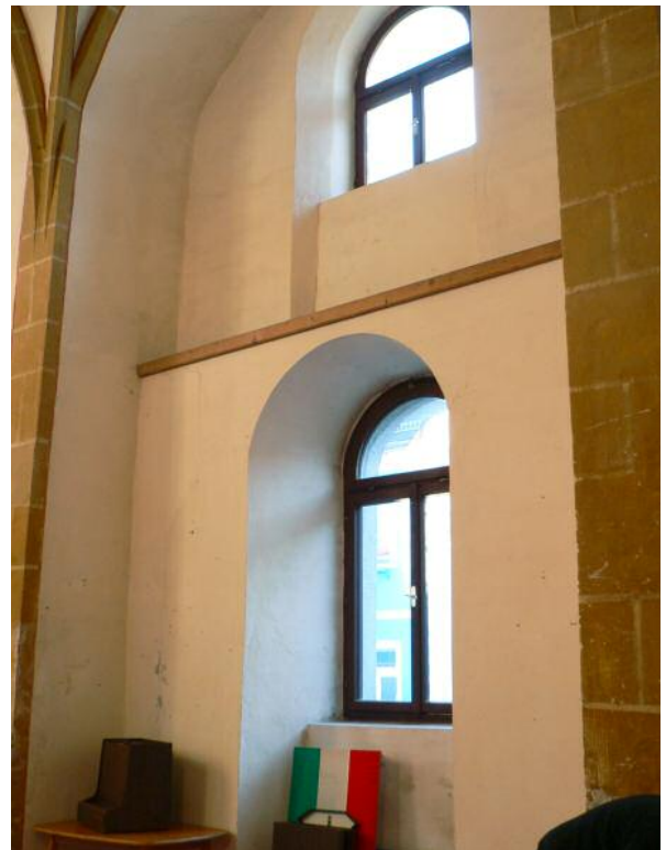
70 Bad Leonfelden, Spitalskirche, Fensterzone an der Südfassade, Innenraum mit verstärktem Mauervorsprung für die Halterung der eingezogenen Zwischendecke.
