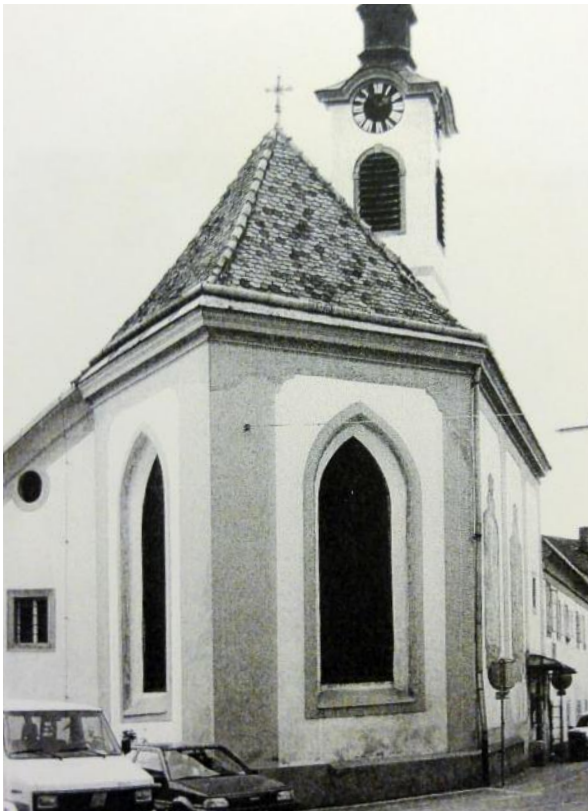
176 Steyr, Bruderhauskirche, Ansicht von Osten.
