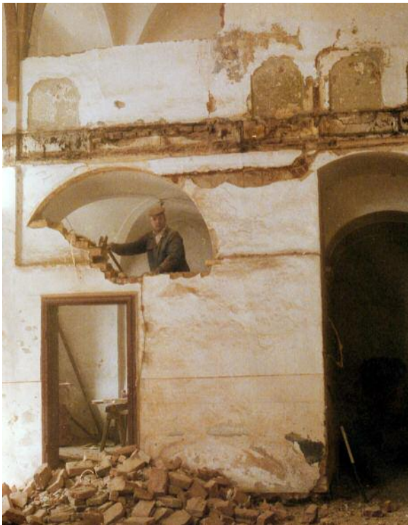
55 Bad Leonfelden, Spitalskirche, Renovierung der Spitalskirche, jüngeres Mauerwerk wurde abgerissen.
