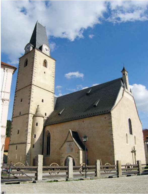
204 Rosenberg, Pfarrkirche, Außenansicht.
