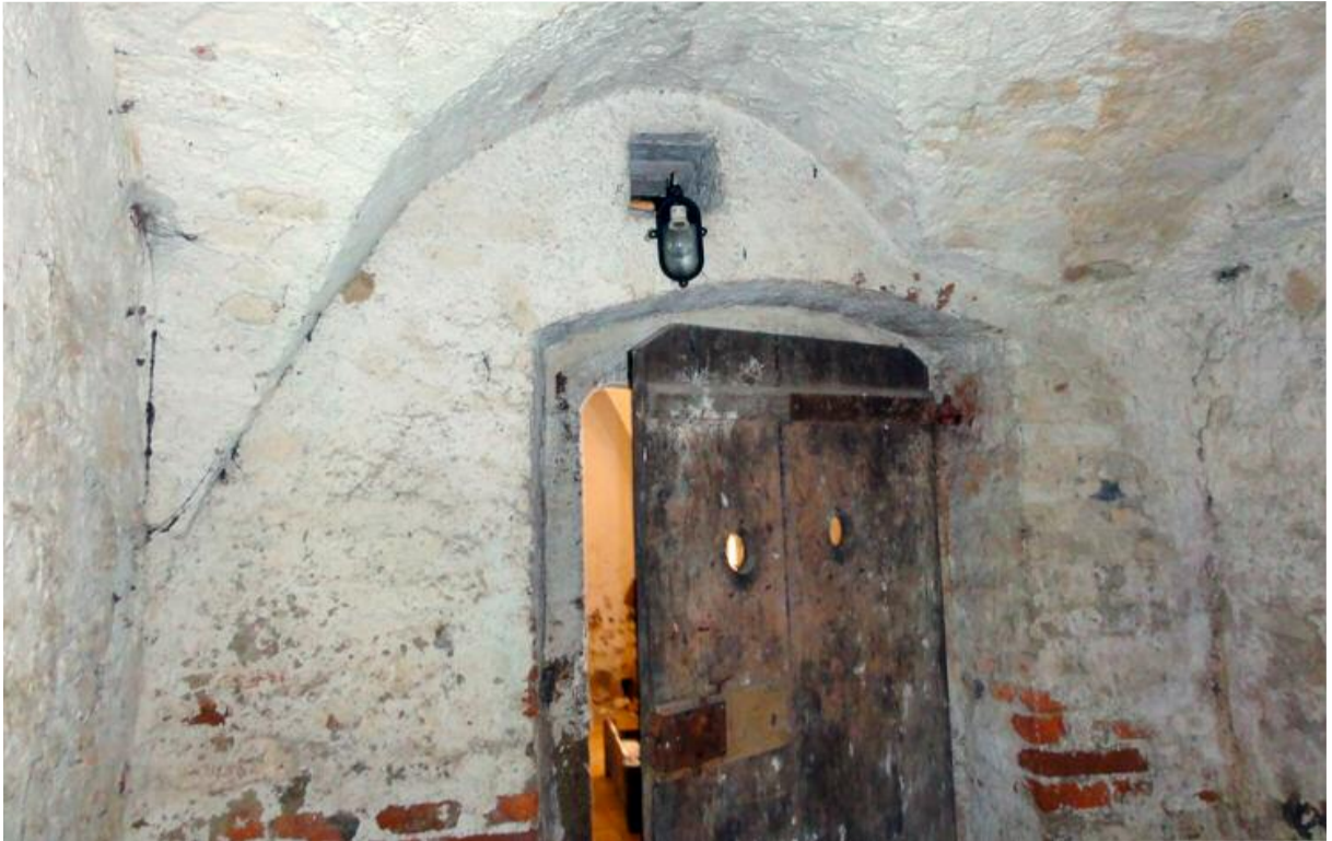
32 Bad Leonfelden, nördliche Kammer mit spätgotischen Schulterbogenportal zum Eingangsbereich hin. Die Zwischenmauer zum Fletz ist nach der Erbauung des Gewölbes eingezogen worden. Der Fletz umfasste damit die ganze Breite des Bürgerspitals. Das spätgotische Portal wurde in die Mauer gebaut und wiederverwendet. Der ursprüngliche Standort ist unbekannt.
