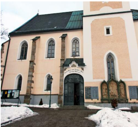
123 Gramastetten, Pfarrkirche, Außenansicht mit südseitigem Haupteingang.
