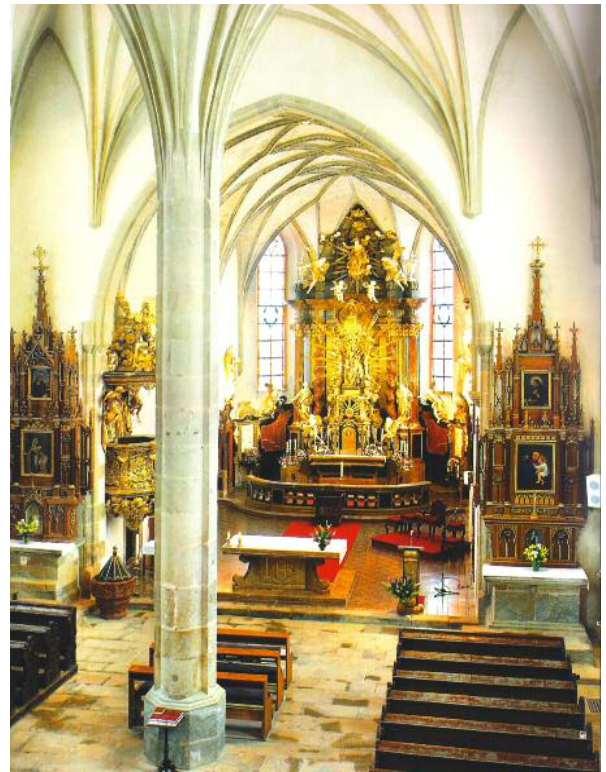
190 Gojau, Einsicht in das Langhaus und Chor.
