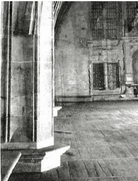
215 Prag, Hradschin, Wladislaw-Saal, Wandpfeilerstützen mit abgekappten Rippen und W-Formation, 1493-1502.
