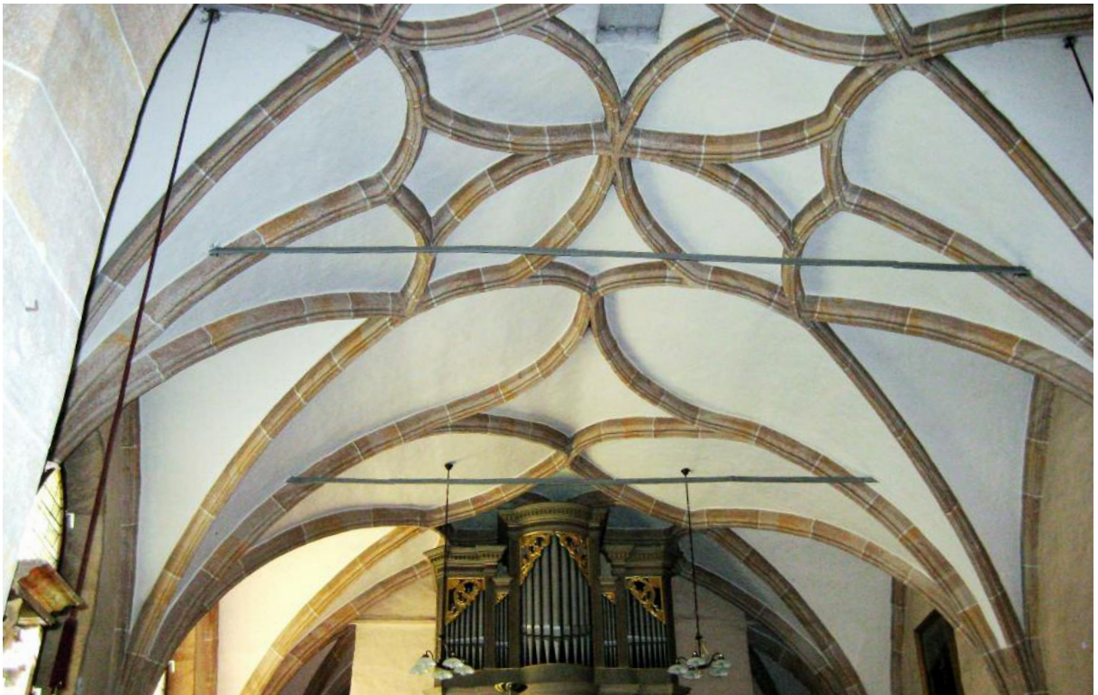
186 St. Lorenzen in der Steiermark, Kombination aus Bogen- und Schlingrippen im Langhaus, um 1515.
