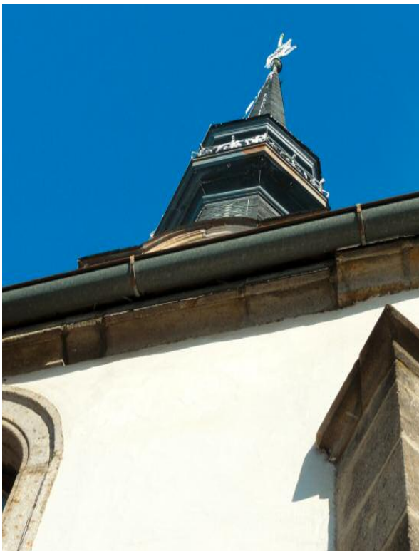
69 Bad Leonfelden, Spitalskirche, einfach gekohltes Dachgesims, ausgebessert und aus neu angestückelten Teilen.
