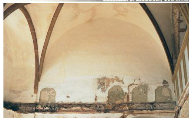
54 unten: Bad Leonfelden, Spitalskirche, Renovierung, 1987: eingezogener Boden wurde abgetragen.
