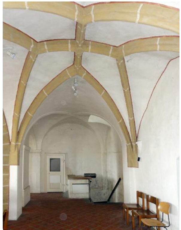
101 Bad Leonfelden, Spitalskirche, Überwölbung der Empore, Sternrippengewölbe mit floralem Schlussstein, im Hintergrund: barocker Treppenaufgang und stuckiertem Kreuzgratgewölbe.
