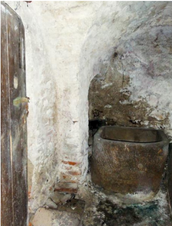
33 Bad Leonfelden, nördliche Kammer mit tragenden Gewölbepfeilern an der Außenwand der Spitalskirche.
