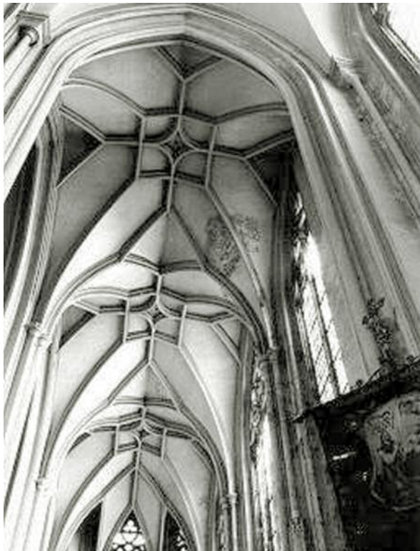
166 Steyr, Stadtpfarrkirche, Einblick ins Seitenschiff mit kastenförmig umrandeten Bogenrippen mit sphärischer Rautenbildung im Gewölbescheitel.
