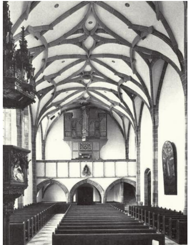
196 Haslach, Einblick ins Langhaus in Richtung Westempore, Netzschlingengewölbe ruht auf Diensten.
