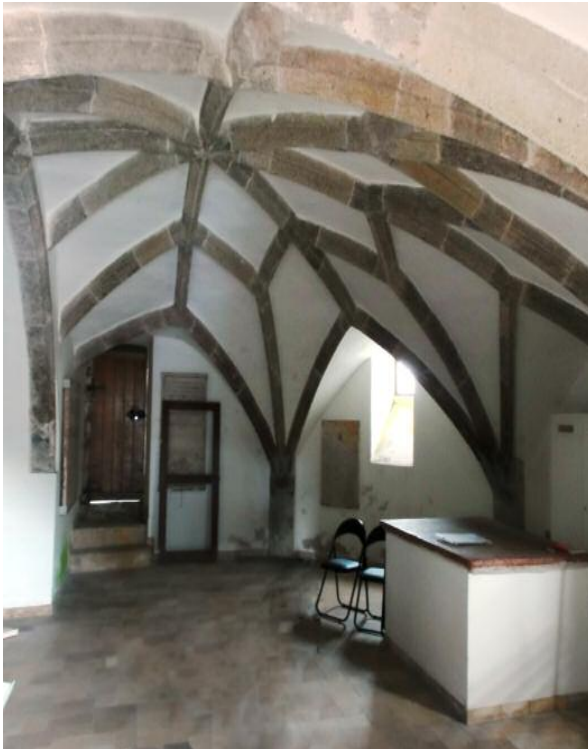
127 Gramastetten, Pfarrkirche, Einblick in die Unterkerche unter dem Chor der Pfarrkirche.
