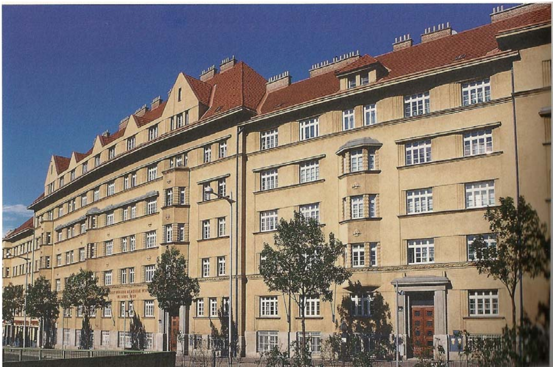
Abb. 8: Metzleinstaler-Hof, erste Bauphase 1919/20, zweite Bauphase 1923-1925, 1050 Wien.
