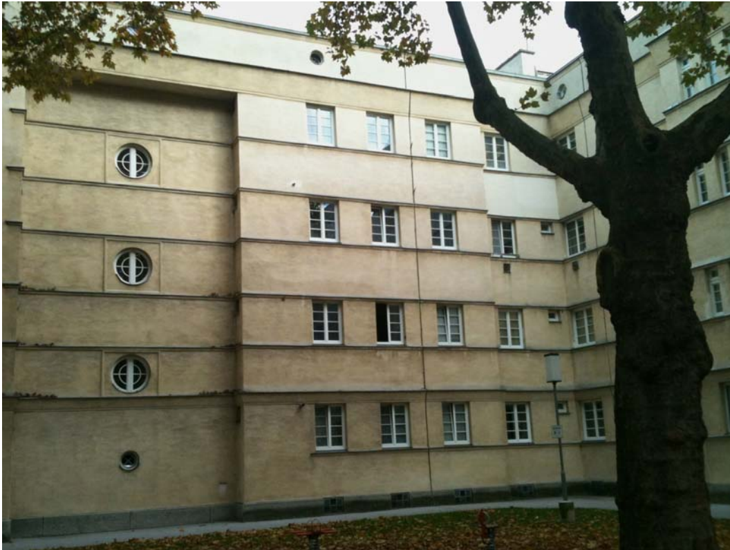
Abb. 21: Nüchterne Innenhoffassade des Karl-Seitz-Hofes, 1926-1931, 1210 Wien.
