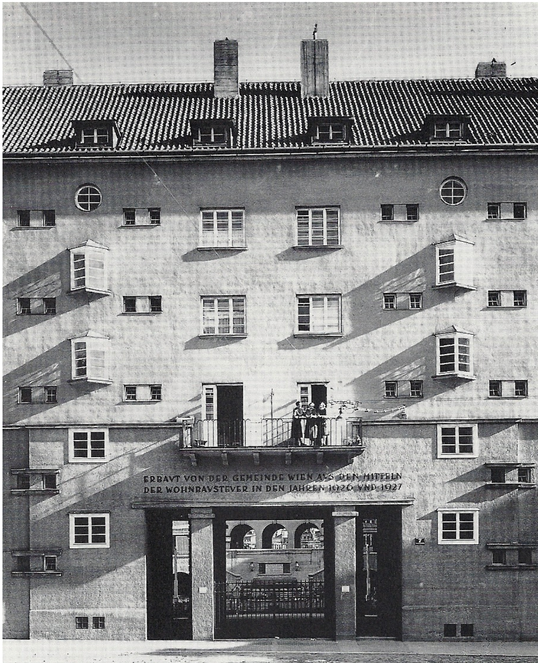
Abb. 9: Fassade, Herwegh-Hof, 1925-1927, gut erkennbar sind hier die Abortfenster, 1050 Wien.
