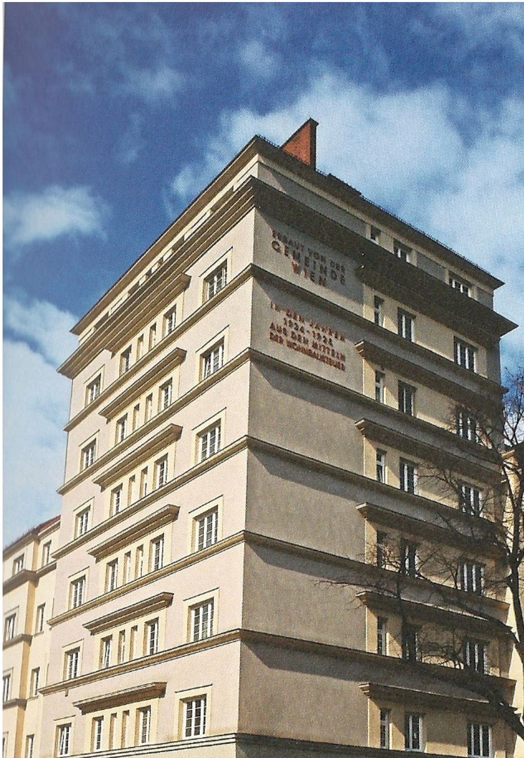
Abb. 25: Expressive Fassadengestaltung, Sandeleiten-Hof, 1924-1928, Detail.
