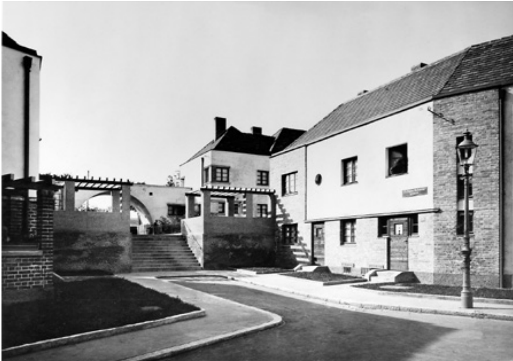
Abb. 48: Siedlung Lockerwiese, 1928-1932, 1130 Wien.
