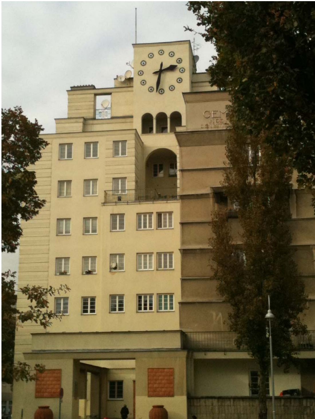
Abb. 63: Karl-Seitz-Hof, Detail Uhrturm an der Jedleseerstrasse.
