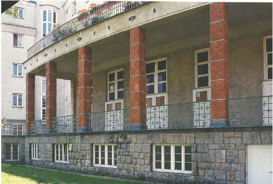
Abb. 64: Karl-Seitz-Hof, Detail schmiedeeiserne Balkongeländer.
