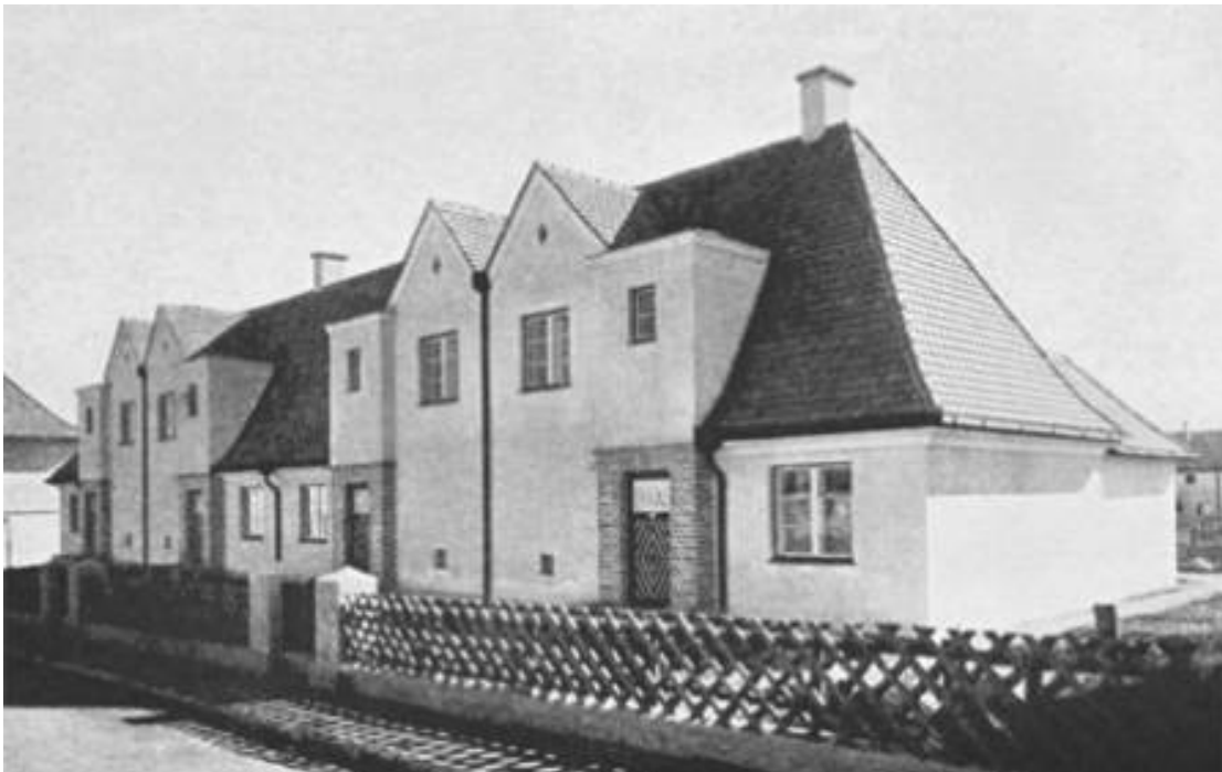
Abb. 48a: Siedlung Hermeswiese, 1924, zweite Bauphase 1928/29, 1130 Wien.
