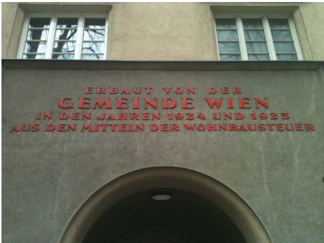
Abb. 4: Typische Schriftzug „ Erbaut aus den Mitteln der Wohnbausteuer “ eines Wiener Gemeindebaus, hier: Obkirchergasse, 1190 Wien.
