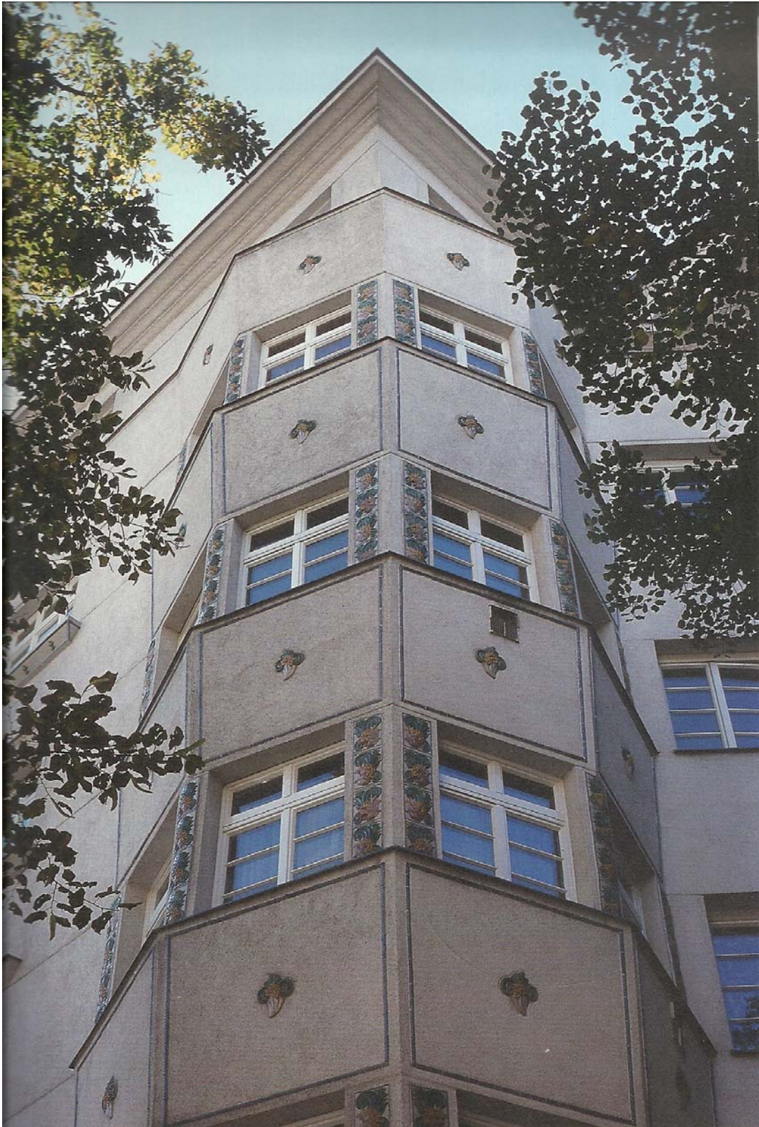
Abb. 31: Metzleinstaler-Hof, Erkerturm, Detail, Erste Bauphase 1919/20, zweite Bauphase 1923-1925, 1050 Wien.
