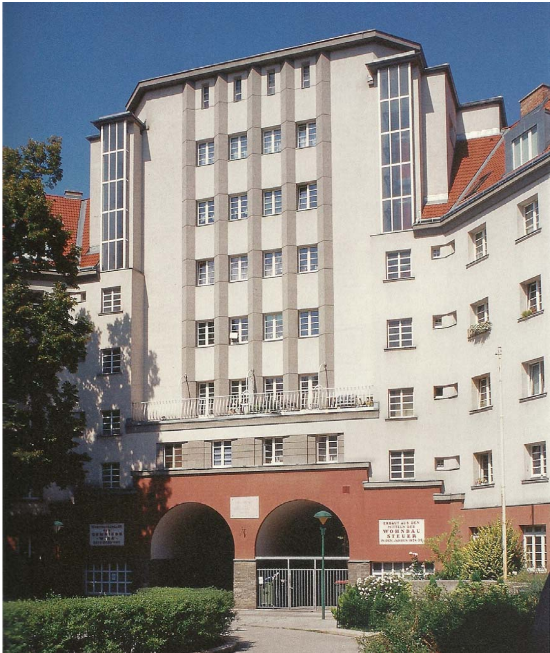
Abb. 32: mächtiges Portal im erhöhten Mittelteil des Edmund Reismann-Hof, 1924-1926, 1120 Wien.
