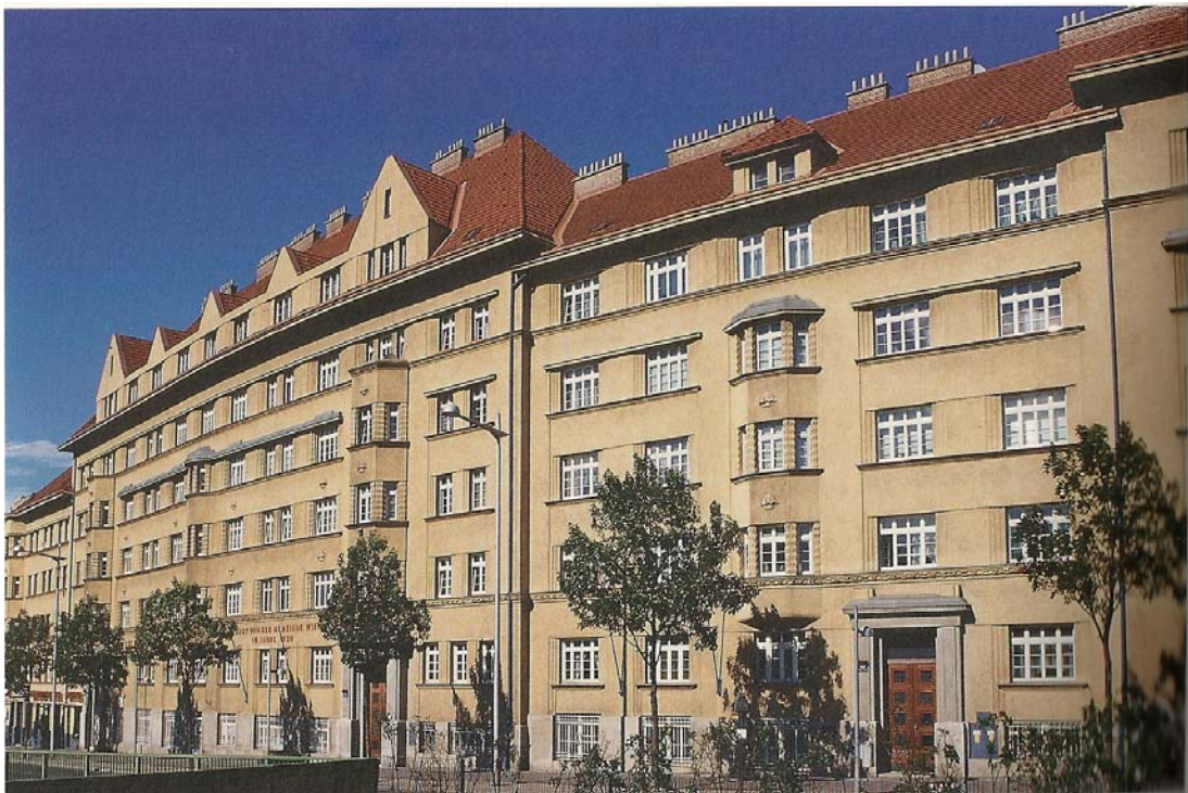
Abb. 20: Metzleinstaler-Hof, erste Bauphase 1919/20, zweite Bauphase 1923-1925, 1050 Wien.
