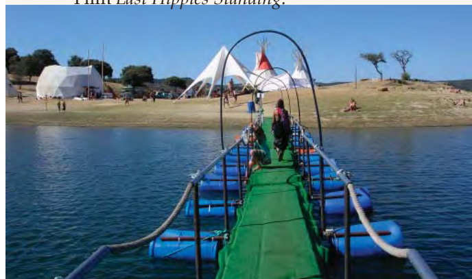
Boom 2008 -Brücke aus Fässern
