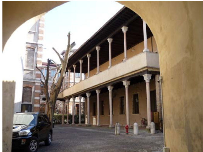
Abb. 1: Reggia Carrarese, Außenansicht, heutiger Zustand.
