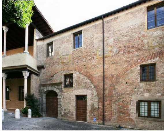
Abb. 77: Anbau zur Loggia Carrarese, ehemals Verbindungsgang zur Befestigungsmauer.
