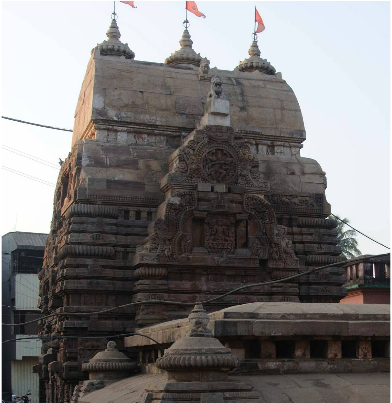
Abb. 22 Ostansicht - ganḍī und mastaka (© WHAV 2009)
