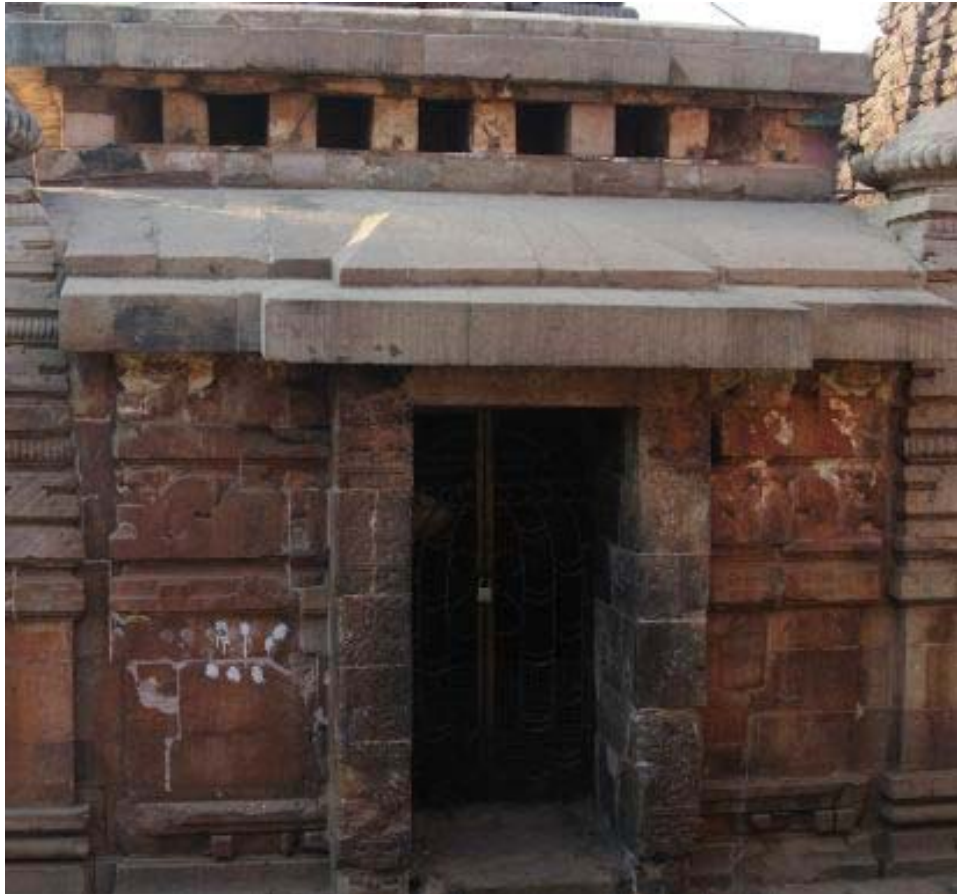
Abb. 33 Detail Eingangsbereich – (©WHAV 2009)
