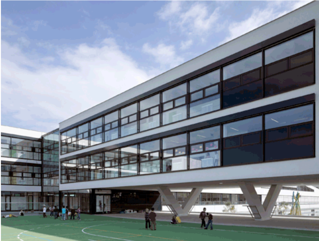
Abb. 17: Campus Monte Laa (URL: http://www.nmpb-architekten.at/index.php?section=51&id=8&id_gal=46&id_gal_sel=256 ; Zugriff am 24.08.2010)
