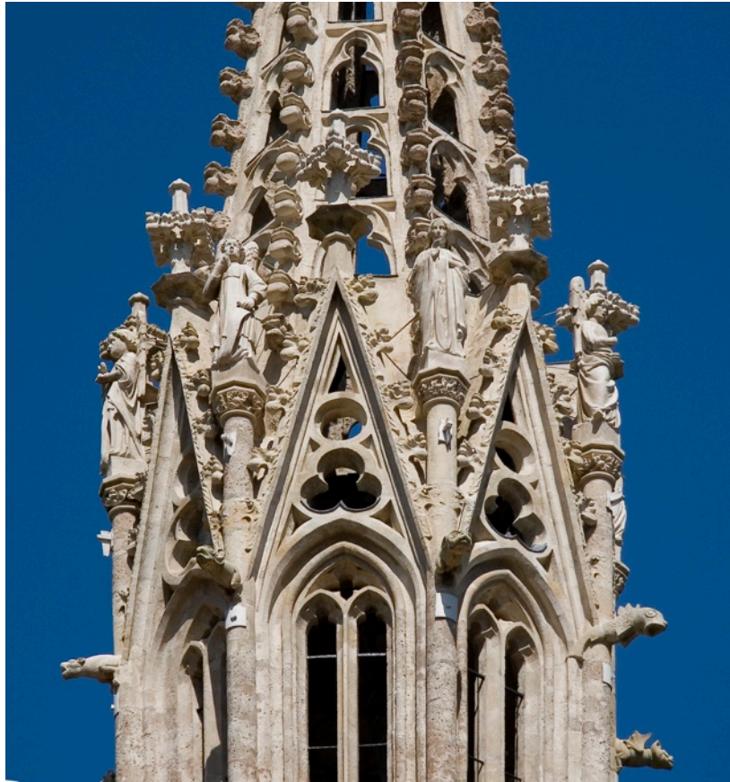
Abb. 59: Maria Straßengel, oberstes Geschoß des Turmes, Ansicht von Osten, Wasserspeier aus dem 19. Jahrhundert und Turmfiguren der Gottesmutter und drei der sieben Engel (jener am rechten Rand wurde im 19. Jahrhundert aus Kunststein ersetzt).
