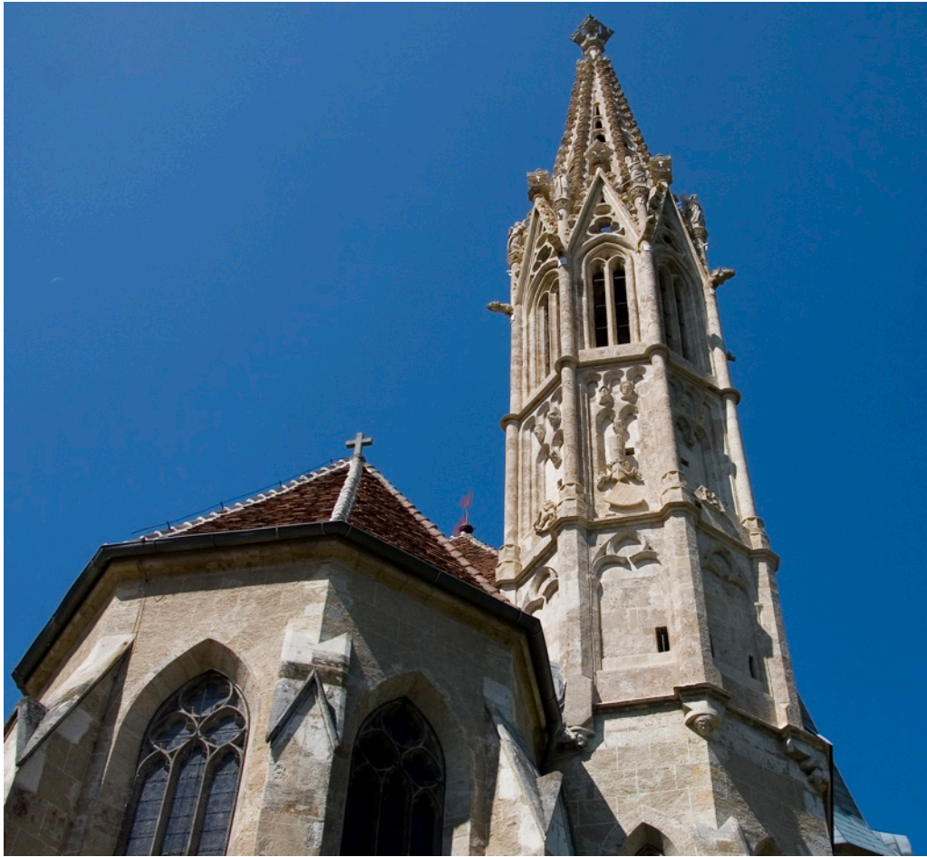
Abb. 51: Maria Straßengel, Turm von Südosten. Sichtbar sind die südliche, die südöstliche und die östliche (hier verschattete) Seite des oktagonalen Turmes.
