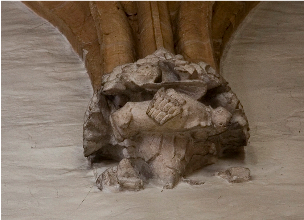
Abb. 45: Maria Straßengel, nördliches Seitenschiff, Nordwand, Wandkonsole zwischen dem dritten und dem vierten Joch von Westen, Wandkonsole WKn3/4.
