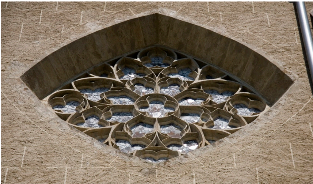
Abb. 90: Maria Straßengel, Maßwerkfenster, Südfassade, erstes Joch von Westen.
