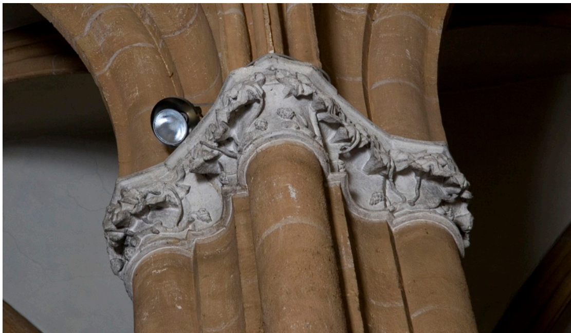
Abb. 42: Maria Straßengel, Blattkapitell des zweiten nördlichen Mittelschiffpfeilers von Westen, Ansicht aus dem Mittelschiff, Blattkapitell Mittelschiffpfeiler BKMn2.
