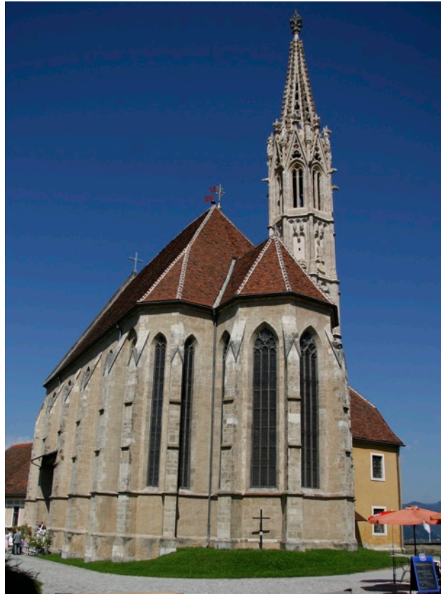
Abb. 1: Maria Straßengel, Ansicht von Südosten.
