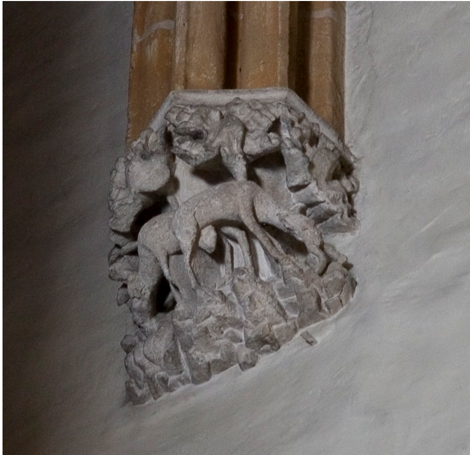
Abb. 47: Maria Straßengel, nördliches Seitenschiff, Nordwand, Wandkonsole zwischen dem ersten und dem zweiten Joch von Westen, Wandkonsole WKn1/2.
