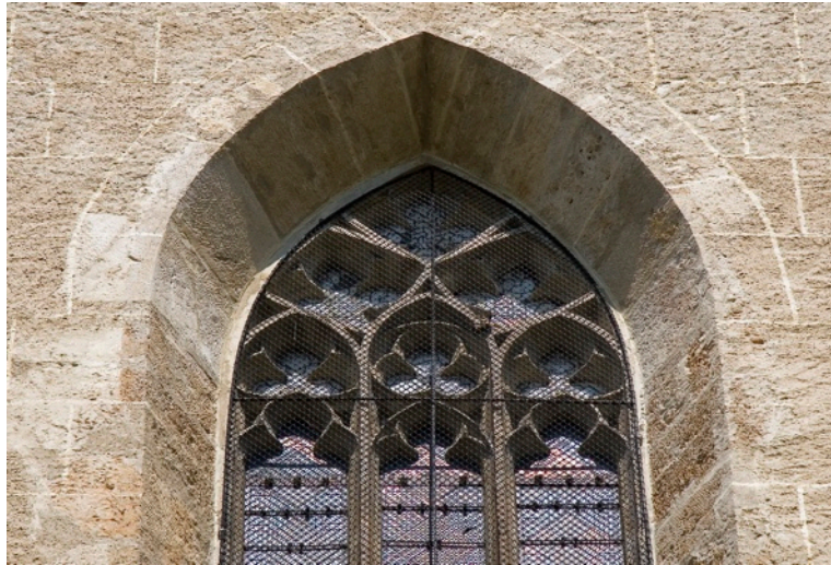
Abb. 61: Maria Straßengel, Maßwerk eines dreibahnigen Fensters, Südfassade, drittes Joch von Westen.
