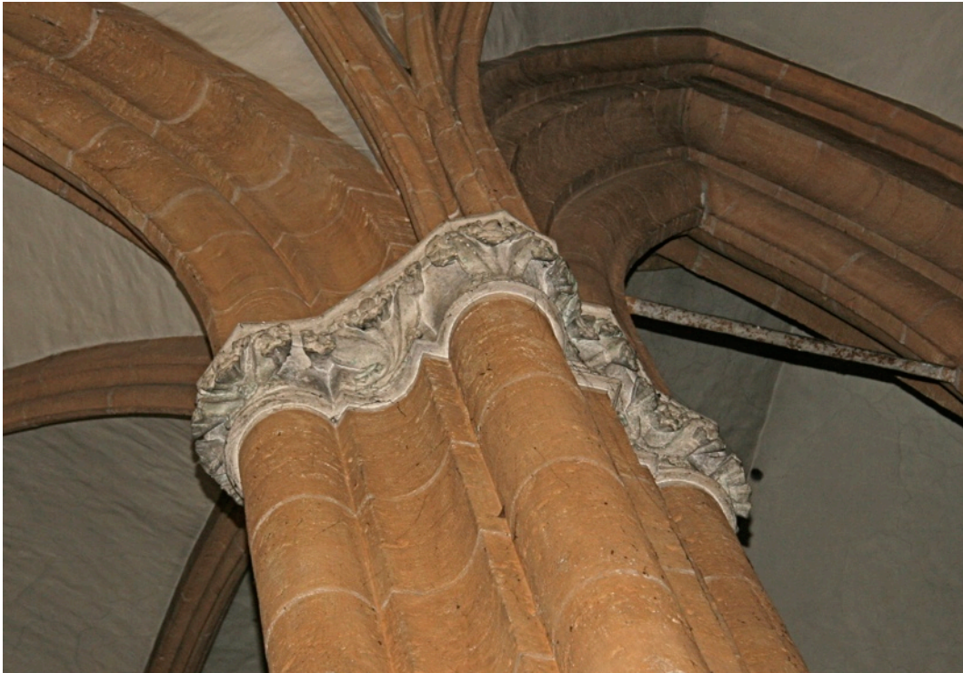
Abb. 33: Maria Straßengel, Blattkapitell des vierten südlichen Mittelschiffpfeilers von Westen, Ansicht aus dem südlichen Seitenschiff, Blattkapitell Mittelschiffpfeiler BKMs4.
