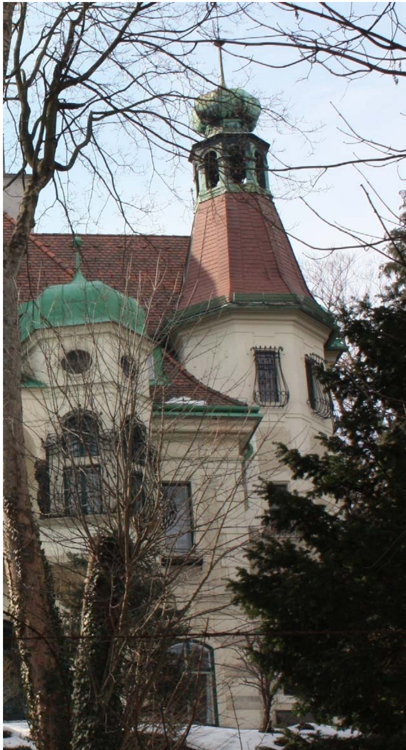
Abb.81: Turm der Villa Schoeller
