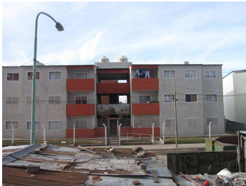
Abbildung 13: Die neu konstruierten Wohngebäude hinter den Wellblechhütten in der villa15 in Buenos Aires.
