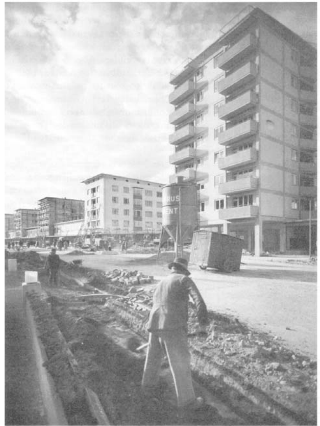
Abb. 39, : Wiederaufbau an der Nordseite der Berliner Straße, 1954
